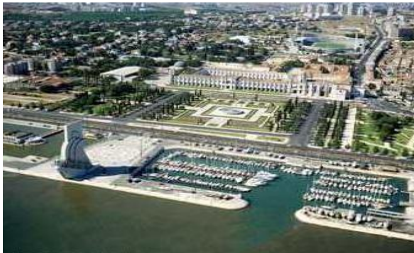
Figura 1.3 - Doca de Recreio de Belém (Fonte: www.penaguiao.pt )
