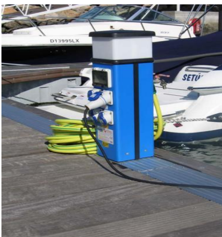
Figura 3.15 – Esquerda: Água e energia elétrica no finger Fonte: (www.grupolindley.com); Direita: Posto de abastecimento de combustível (Fonte: www.grupolindley.com)
