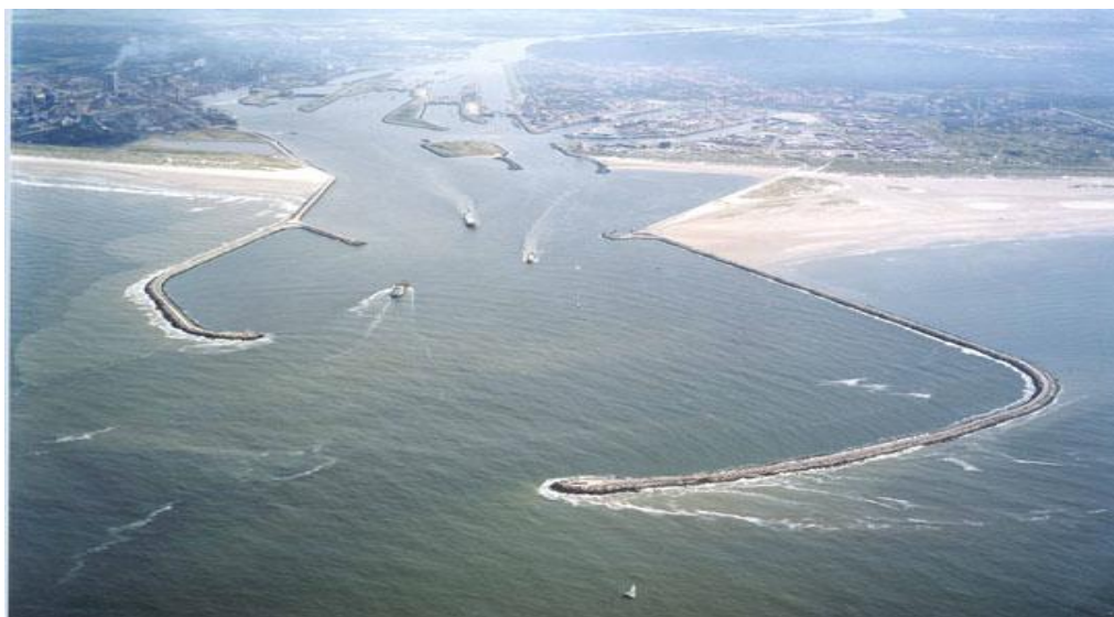
Figura 2.7 - Quebramares portuários (Fonte: www.engenhariacivil.com )
