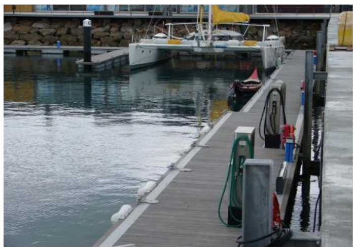
Figura 3.15 – Esquerda: Água e energia elétrica no finger Fonte: (www.grupolindley.com); Direita: Posto de abastecimento de combustível (Fonte: www.grupolindley.com)
