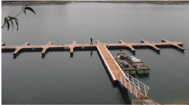
Figura 3.9 - Equipamento flutuante em alumínio (Fonte: www.grupolindley.com )
