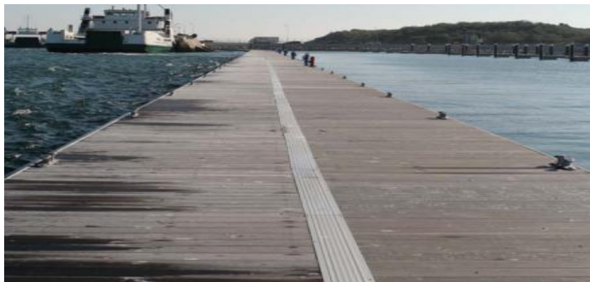
Figura 3.10 - Passadiço construído em betão (Fonte: www.grupolindley.com )
