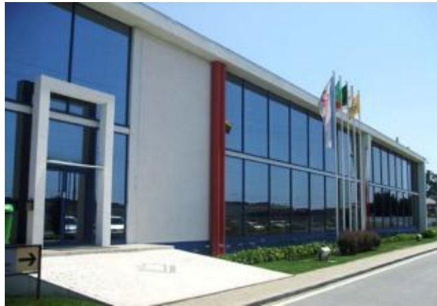
Figura 1 - Instalações BOSCH Termotecnologia S.A., Aveiro [1]
