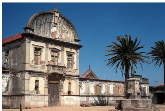
Imag. 29 – Fabrica Brandão Gomes em ruínas, 1992 1
