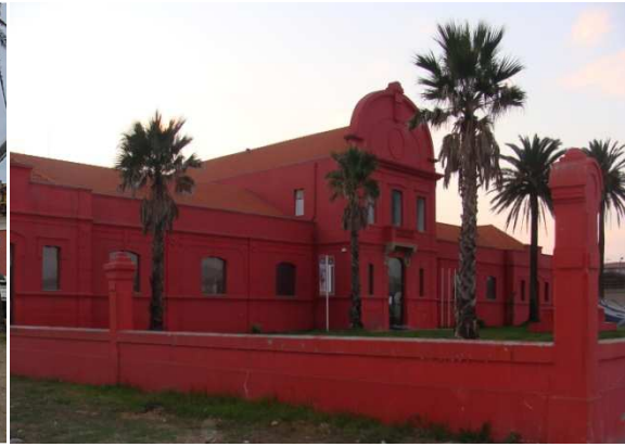
Imag. 31 – Estado actual da fachada do FACE
