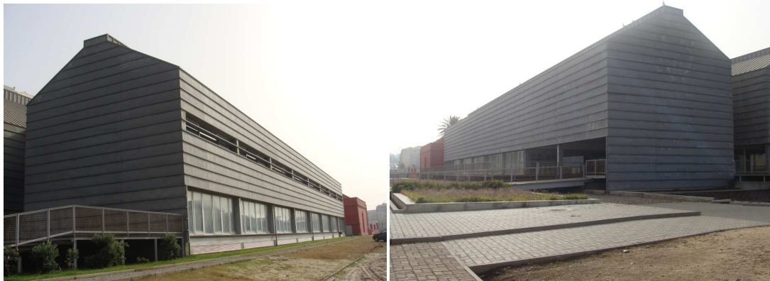
Imag. 35 – Retaguarda do FACE vista sul Imag. 36 – Retaguarda do FACE, vista norte.
