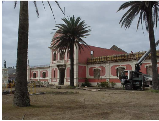
Imag. 30 – Obras de requalificação, 2004 156
