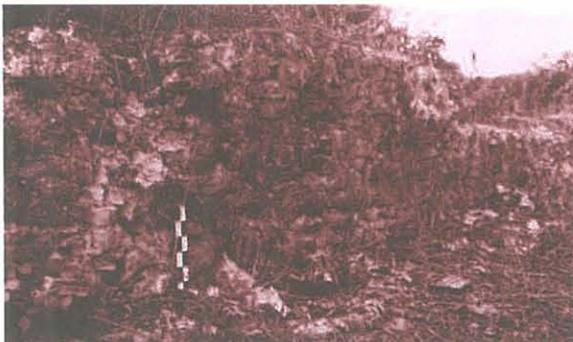
Fig. 3 - Parede em "alvenaria de pedaços de cortiça" na Herdade da Cascada, Montemor-o-Novo (Créditos: Rui Ferreira, 2000).
