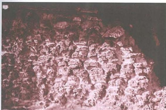
Fig. 1 - Parede em "alvenaria de pranchas de cortiça" na Herdade da Gralheira, Montemor-o-Novo (Créditos: Rui Ferreira, 2000).
