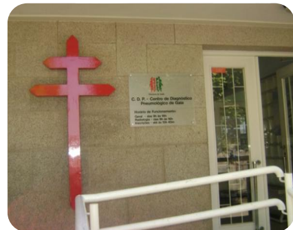
Figura 13 - Fachada do CDP de Vila Nova de Gaia
