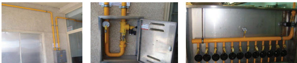
Fig. 6.22 – Nova instalação de gás
