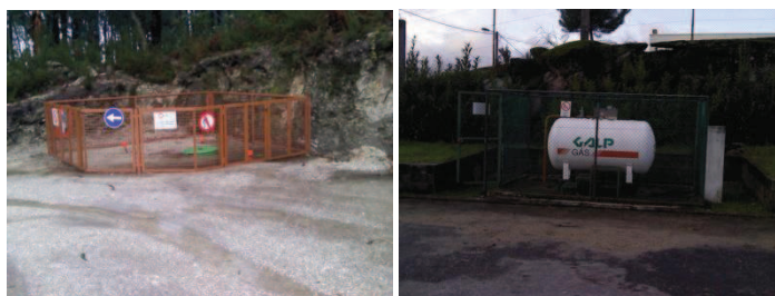
Fig. 4.14 – Exemplos de reservatórios de gás “enterrado” e “à superfície”
