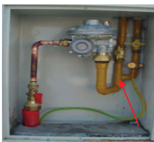
Fig. 4.9 – Exemplo de Instalação de Gás com duas colunas montante
