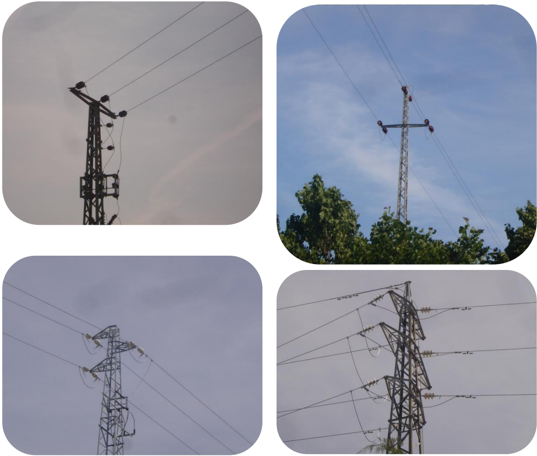
Figura 2.4 - Armações existentes.
