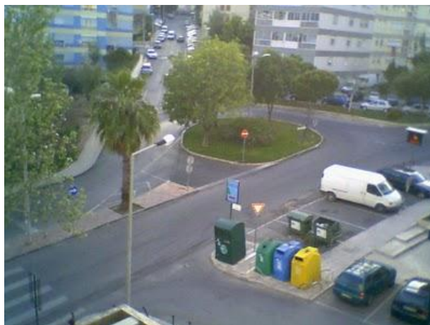
Figura 30 - Rotunda com uma má deflexão [3]
