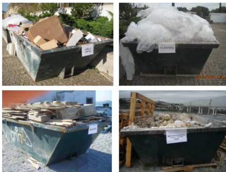
Fig.5.9 – Triagem de RCD em Obra [20]
