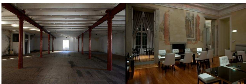
Fig. 5.7 e 5.8 – Pavimentos em Madeira presentes no Edifício da Moagem e na Reabilitação da Pousada do Freixo
