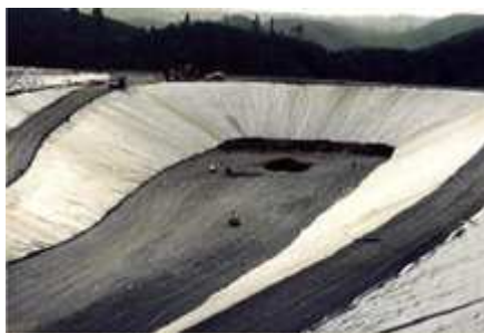
Fig. 3.8 – Aterro para RCD [16]
