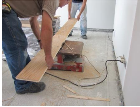
Fig. 5.27 – Corte longitudinal com serra eléctrica.
