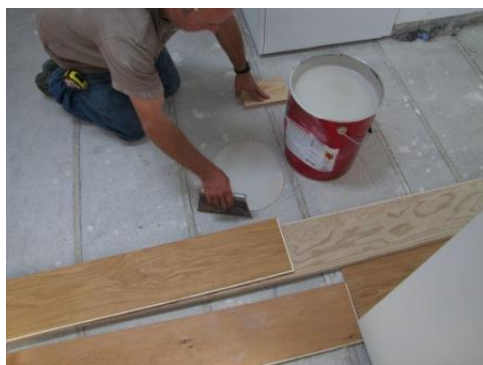
Fig. 5.22 – Espalhamento com espátula denteada.
