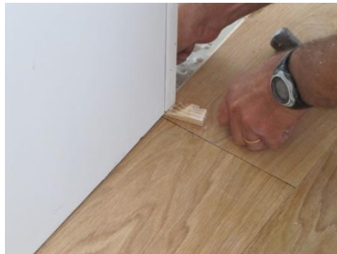
Fig. 5.28 – Cunha auxiliar de aperto.
