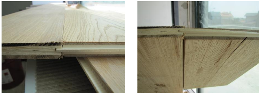
Fig. 5.31 – Pormenores do encaixe entre réguas.
