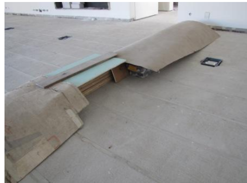
Fig. 5.18 – Armazenamento do soalho.
