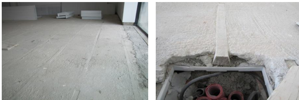
Fig. 5.17 – Suporte em betonilha e ripado de madeira.
