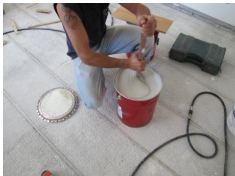
Fig. 5.21 – Homogeneização da cola.
