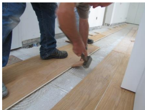
Fig. 5.25 – Encaixe da segunda fiada.
