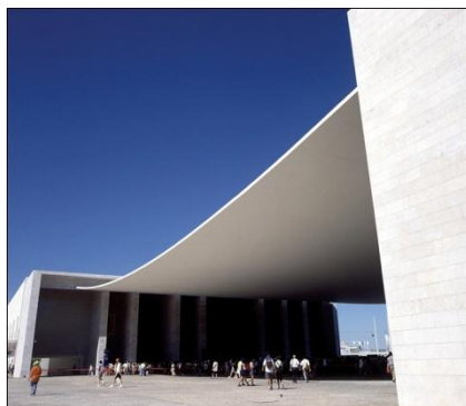
Fig. 2.2 – Estrutura em betão armado, Pavilhão de Portugal [10]
