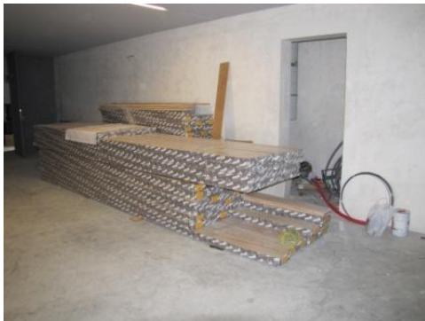
Fig. 5.18 – Armazenamento do soalho.
