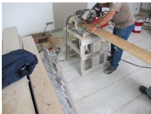
Fig. 5.20 – Corte transversal com serra eléctrica.
