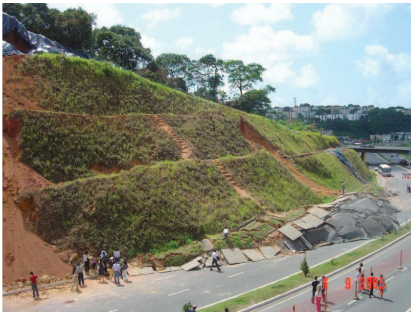
Fig. 2.7 – Escorregamento por translação (Gerscovich, 2009)
