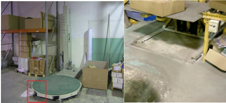
Ilustração 1 e 2: Problemas: limitação de acesso à máquina de filmagem e limitação de layout ao rebaixar a superfície de circulação.
