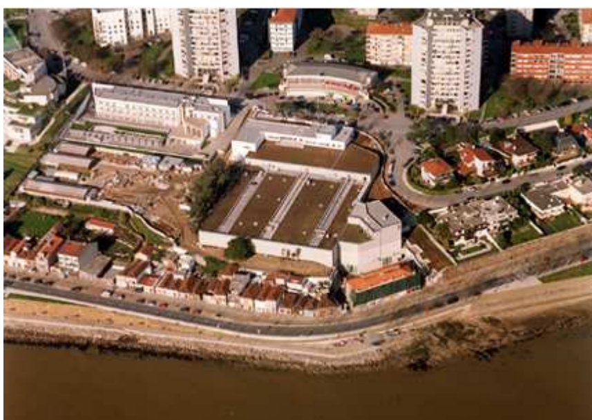
Figura 16 – Vista aérea da ETAR de Sobreiras e estuário do Douro ( www.ambienteportugal.com , acedido a 2011/06/30)
