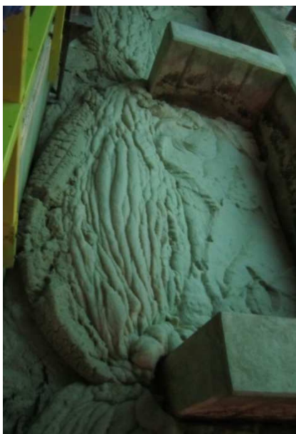
Figura 8 – Espumas à entrada do decantador secundário (2011/06/09)
