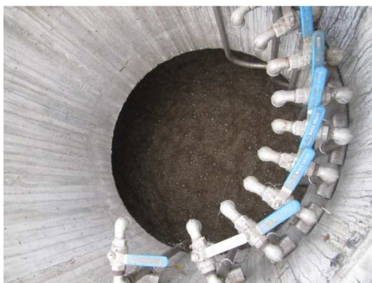
Figura 10 – Formação de espuma à superfície do arejamento num reactor biológico (2011/03/30)
