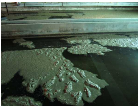
Figura 11 – Persistência de espumas à superfície do decantador secundário (2011/05/04)
