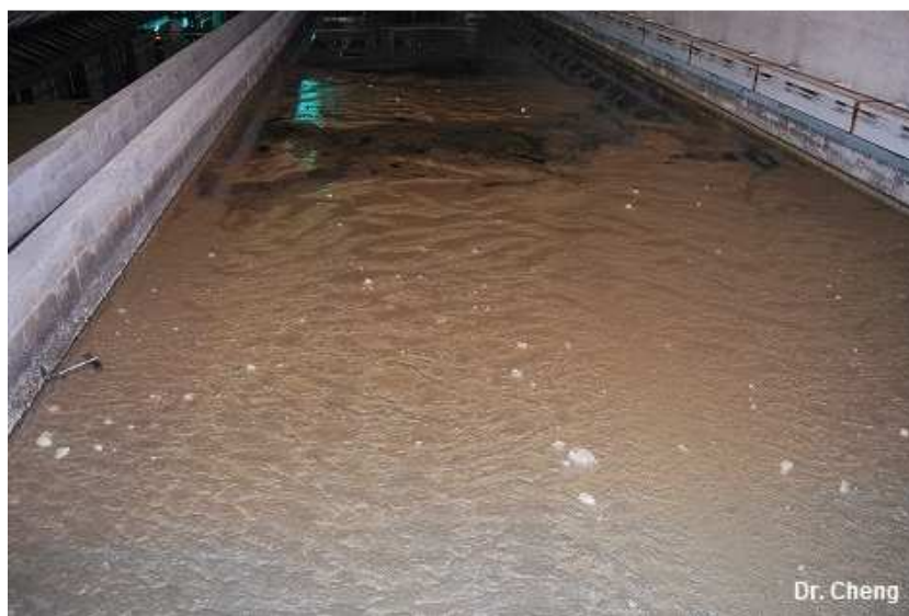
Figura 19 – Imagem de um decantador secundário com formações de sólidos à superfície (tipo espuma)
