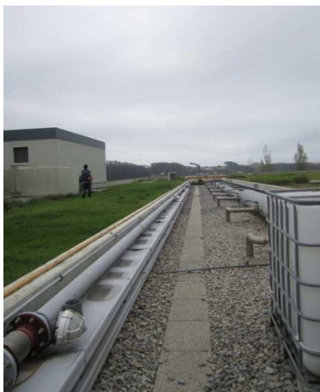
Figura 63 – Vista do tipo de configuração de um dos reactores biológicos da ETAR de Sobreiras que limita a implementação de modificações de processo
