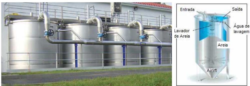
Figura 64 – Filtros de areia de volume upflow contínuo (CONTIFLOW® Sandfilter CFSF). Imagem de Huber Technology
