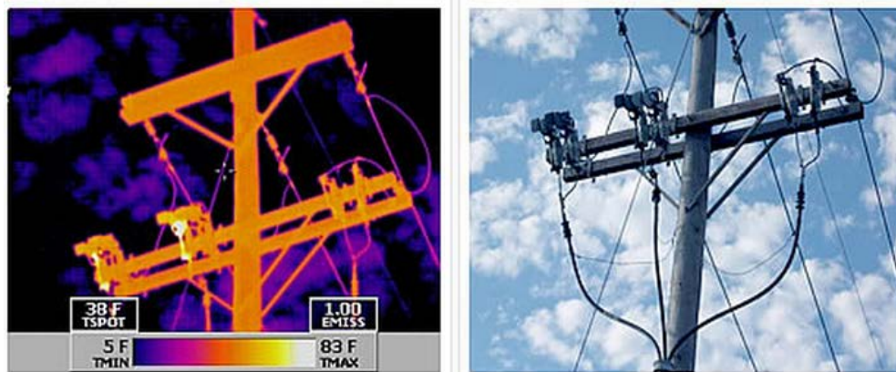
Figura 3.5: Linhas de Transporte e Distribuição de Energia[21]
