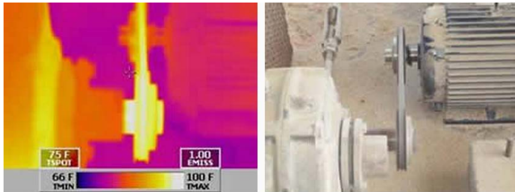
Figura 3.13: Desalinhamento de Roldanas[21]
