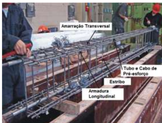
Fig.3.12 – Ilustração do conjunto de armaduras em fase de amarração [36].
