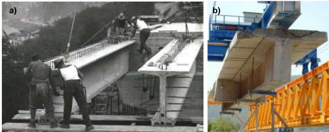
Fig.1 – Viaduto “Sopra le Cantine” na Suíça: (a) Construção do viaduto em 1967; (b) Remoção das vigas para análise ao corte em 2003.
