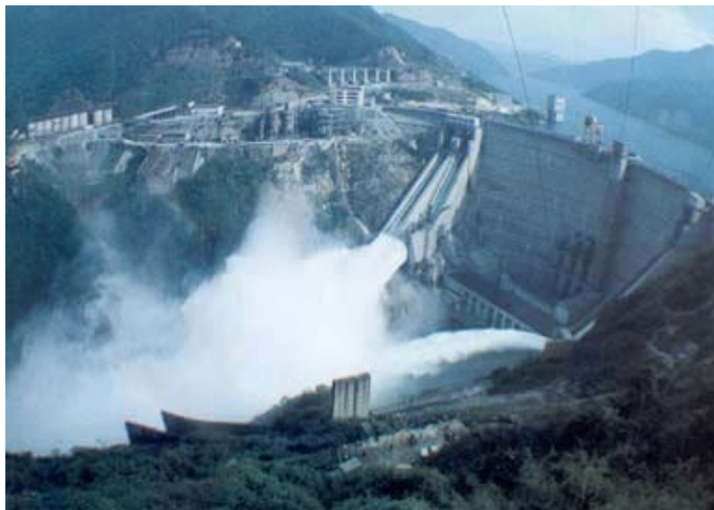
Fig. 2.3. – Bacia de dissipação por jacto
