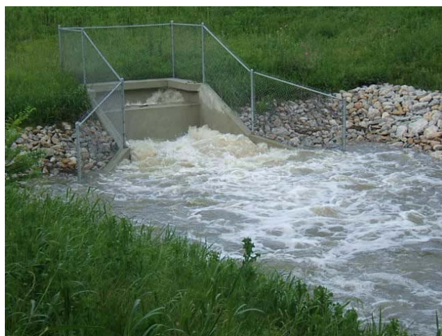
Fig. 2.2. – Bacia de dissipação por impacto (Fonte: Natural Resources Conservation Service)
