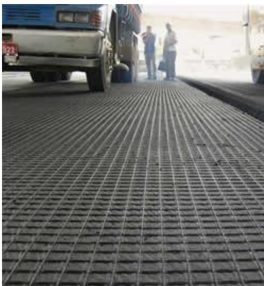
Fig. 2.19 – Utilização da geogrelha (Revista Técnica, 2003)
