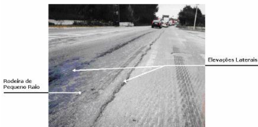
Fig. 2.10 – Rodeiras por deformação permanente das misturas betuminosas (Pavimentos Rodoviários, 2009)
