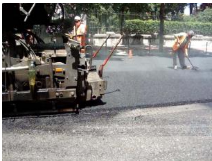
Fig. 3.13 e 3.14 – Aplicação de uma mistura betuminosa SMA com fibras na Avenida do Brasil (JAOP, 2010)
