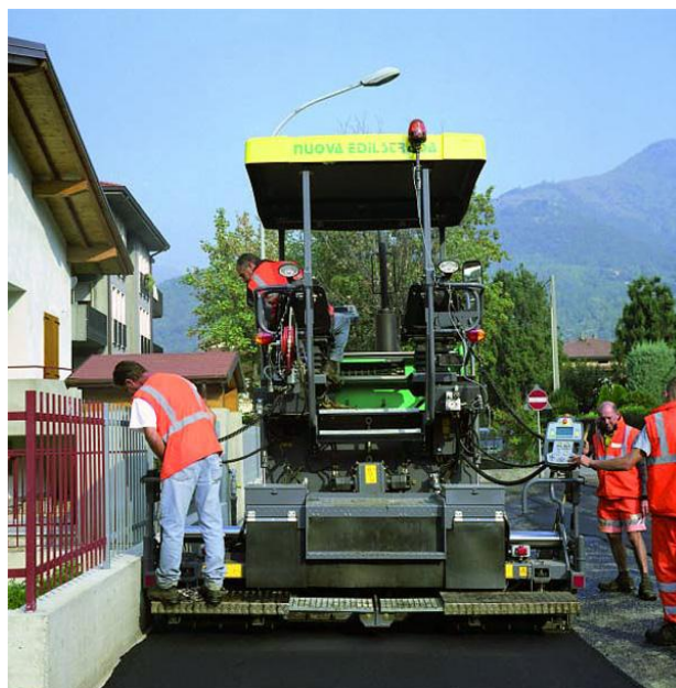
Fig. 2.5 – Aplicação da camada de desgaste de 4cm (Voegelé, 2008)
