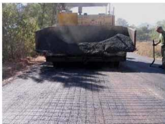
Fig. 2.20 e 2.21 – Reforço de misturas betuminosas com malhas de aço (Engenhariacivil, 2010)
