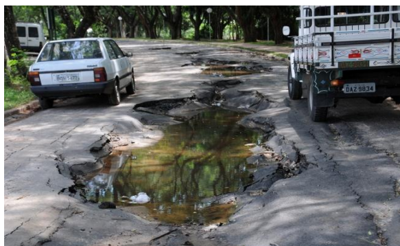
Fig. 2.14 – Abatimento da camada inferior (Semae, 2011)
