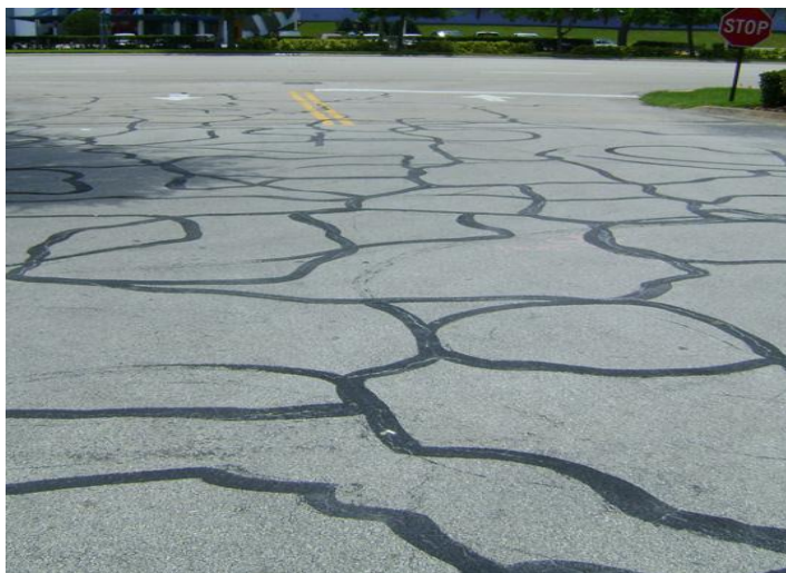
Fig. 2.17 – Selagem de fendas na superfície de um pavimento (Engenhariacivil, 2010)
