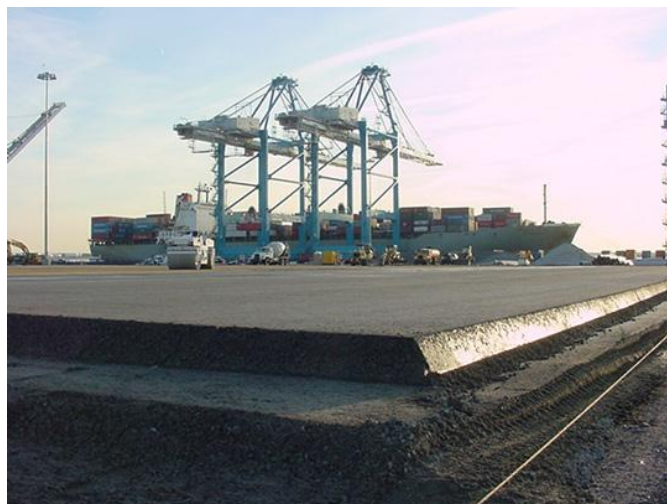
Fig. 2.3 – Estrutura de um pavimento (Engenhariacivil, 2010)
