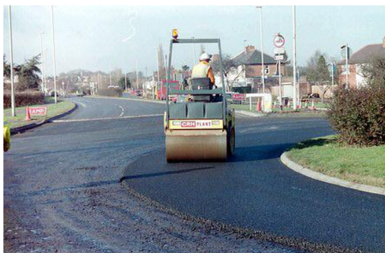
Fig. 3.8 – Compactação de uma mistura SMA numa rotunda (Highways Maintenance, 2006)
