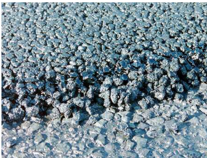
Fig. 3.2 – Aplicação de uma mistura betuminosa do tipo SMA (Highways Maintenance, 2006)
