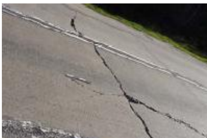
Fig. 2.18 – Reflexão de fendas transversais e longitudinais (Pavimentos Rodoviários, 2009)
