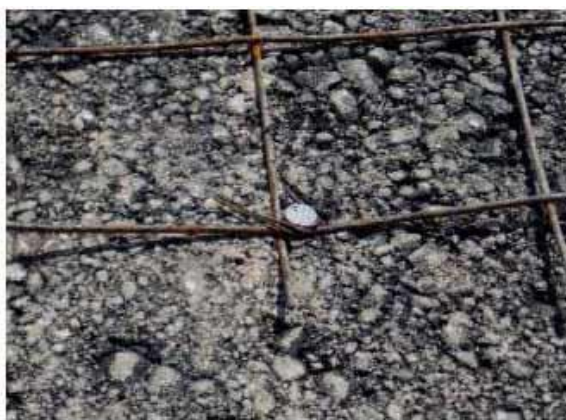
Fig. 2.20 e 2.21 – Reforço de misturas betuminosas com malhas de aço (Engenhariacivil, 2010)
