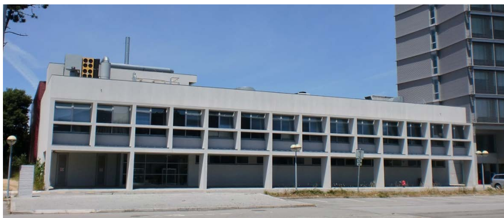
Figura 36 - Fotografia do Edifício em estudo.
