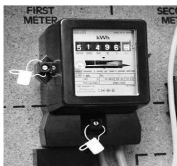
Figura 3 - Contadores eléctricos tradicionais.
