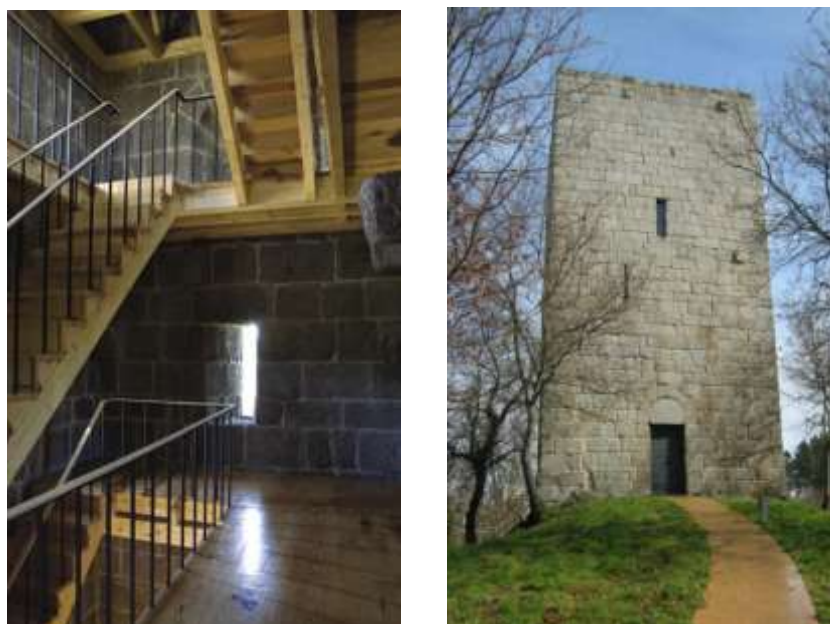
Figura 5. 2 - Torre de Vilar após a intervenção
