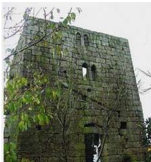
Figura 5. 4 – Vista geral da Torre dos Alcoforados (Costa et al, 2007).
