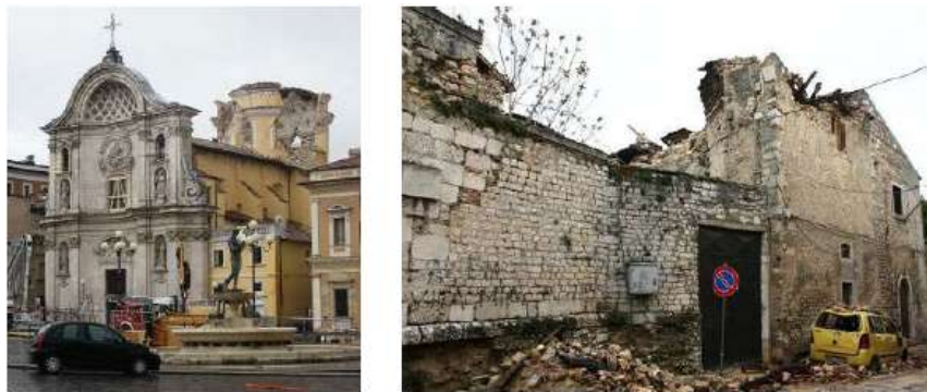
Figura 2. 11- Danos em estruturas de alvenaria tradicional (Costa et al, 2010).
