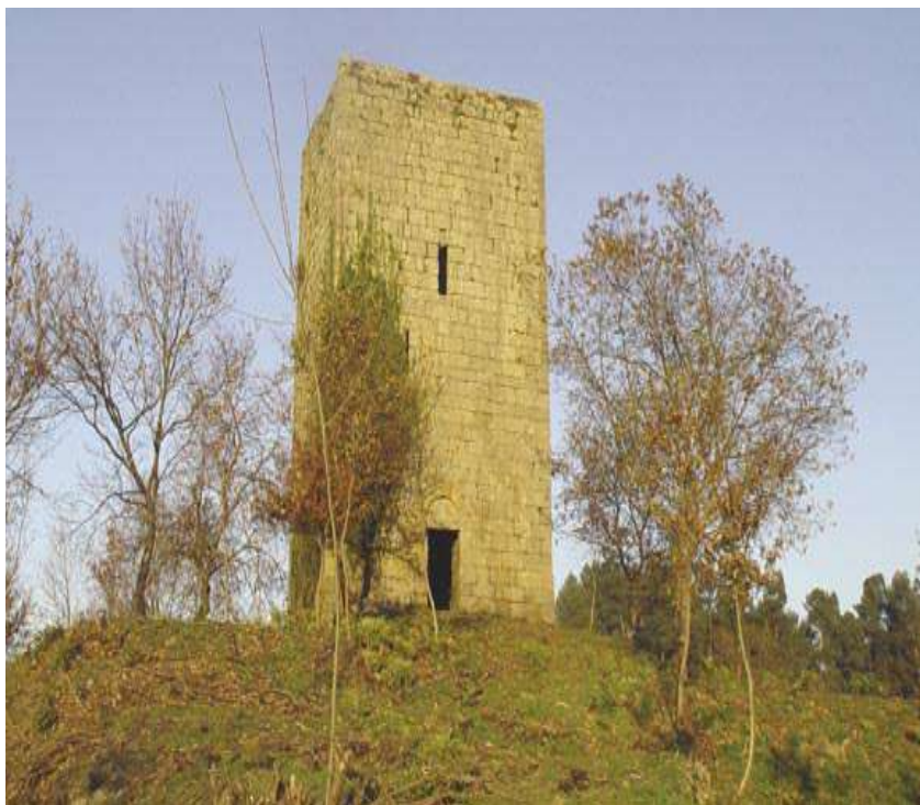
Figura 5. 1 -Vista geral da Torre de Vilar antes da intervenção
