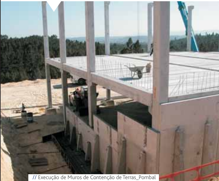
// Execução de Muros de Contenção de Terras_Pombal
