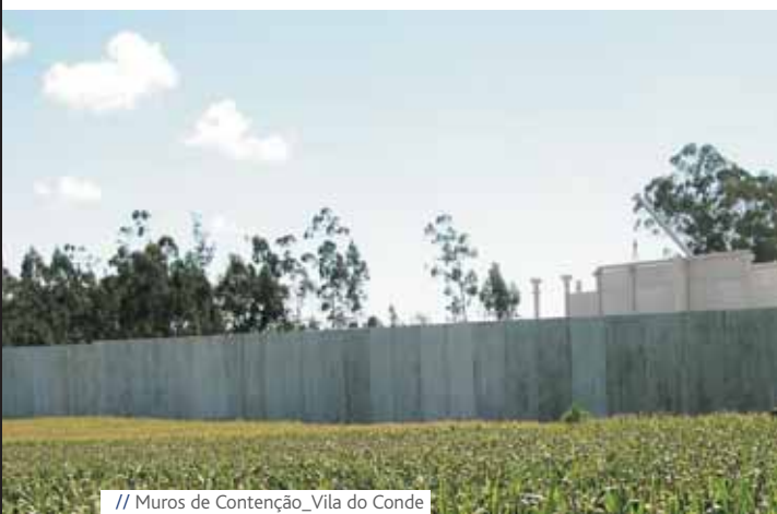
// Muros de Contenção_Vila do Conde
