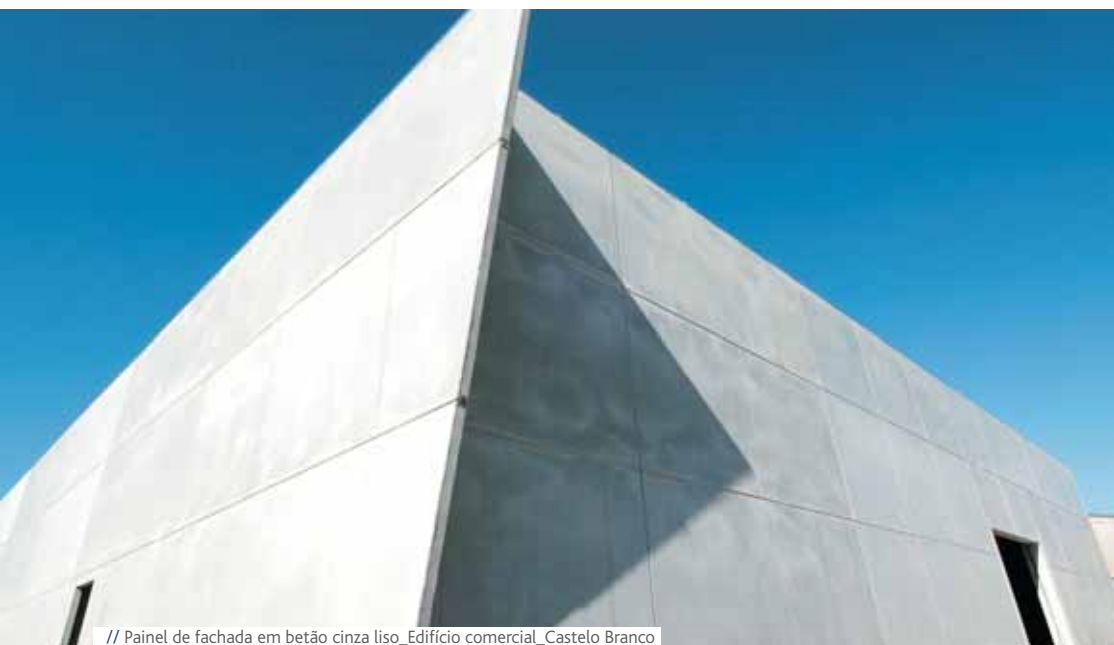
// Painel de fachada em betão cinza liso_Edifício comercial_Castelo Branco
