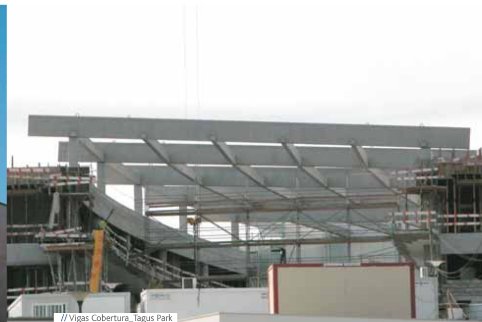
// Vigas Cobertura_Tagus Park
