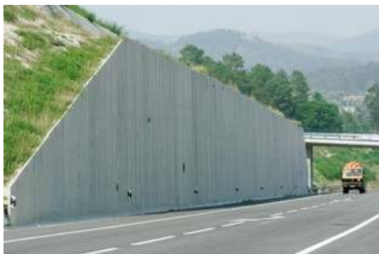
Fig. 2.3 – Muro de Suporte [14]
