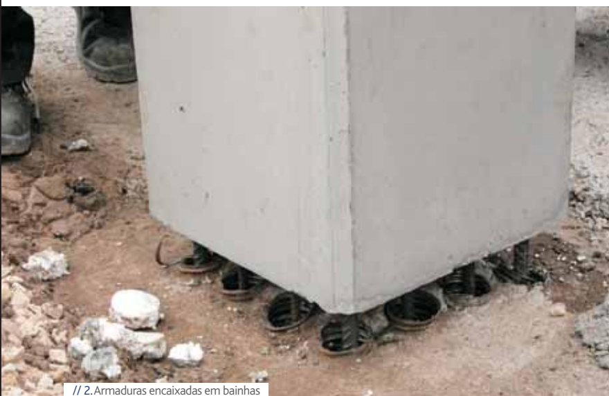
// 2. Armaduras encaixadas em bainhas
