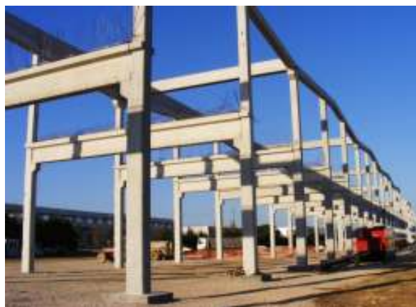
Fig. 2.6 – Sistema de Estruturas de Pórticos [8]
