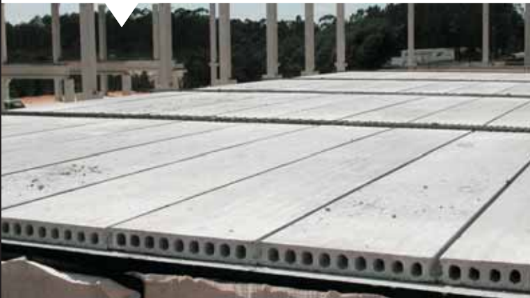
Painel Tipo: LAV12 || Espessura: 0,12 (m) || P.Próprio: 1,94(kN/m 2 )
