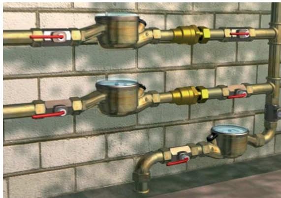
Fig. 2.35 Uso de UFR na rede de distribuição (Yaniv, s/data (b))
