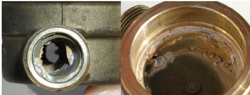
Fig. 2.22 Acumulação de calcário no interior de um contador (Arregui, et al., 2005)
