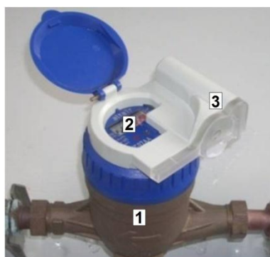
Fig. 2.38 – Unidade local. 1.contador 2.totalizador 3.emissor de impulsos e módulo de comunicação
