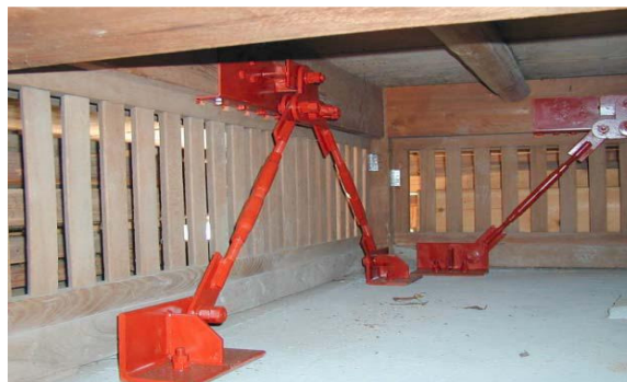
Figura 28 – Constituição de um amortecedor friccional e seu aspecto depois de instalado num edifício, [6] e [3]
