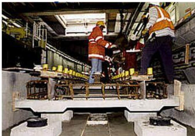
Fig. 3. 7 – Construção de uma via férrea em laje flutuante (Tiflex Limited, Maio de 2010).
