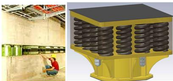
Fig. 3. 9 – Implementação de sistemas de apoio elásticos e esquema representativo (GERB Vibration Control System, Junho 2010).
