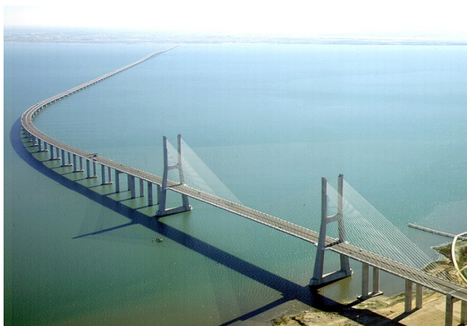
Fig.1.5. – Ponte Vasco da Gama [2]
