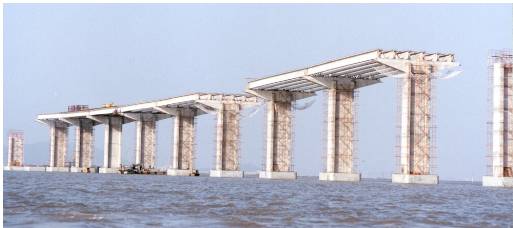
Fig.1.1. – Exemplo de uma ponte construída com recurso à pré-fabricação [2]
