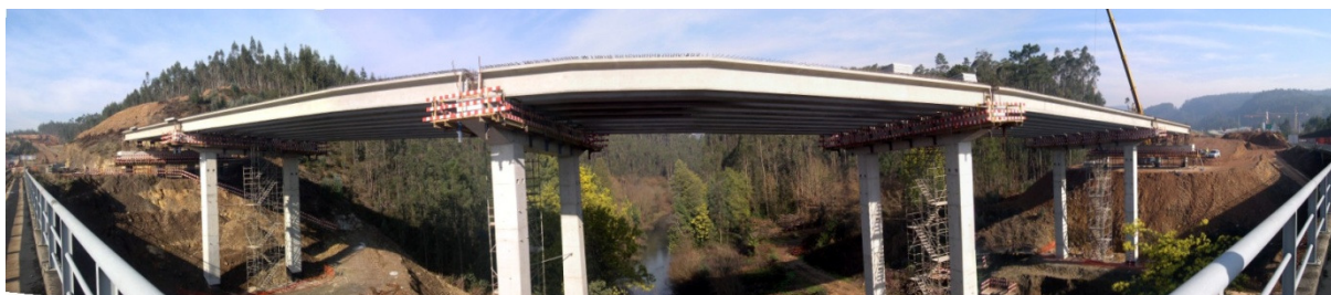
Fig.1.2. – Exemplo de uma ponte construída com recurso à pré-fabricação [3]
