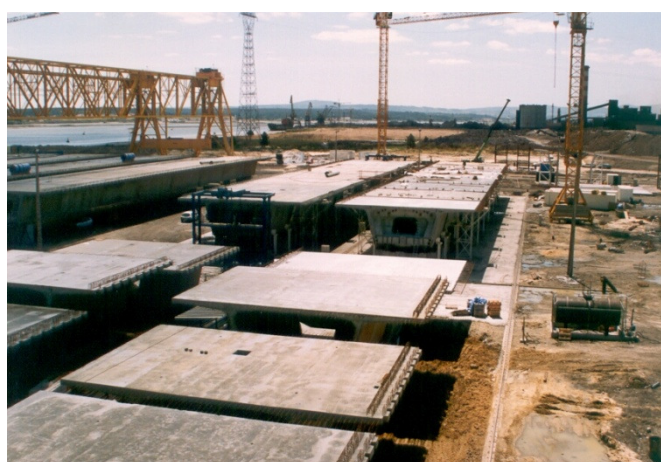
Fig.1.4. – Aduelas em obra prontas para ser montadas [2]
