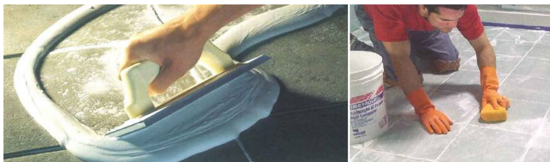
Figura 4.26 - Preenchimento de juntas [46] / Limpeza do cerâmico [46]
