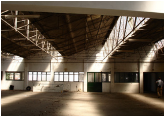
Figura 4.10 - Reabilitação de cobertura em fibrocimento, com remoção
