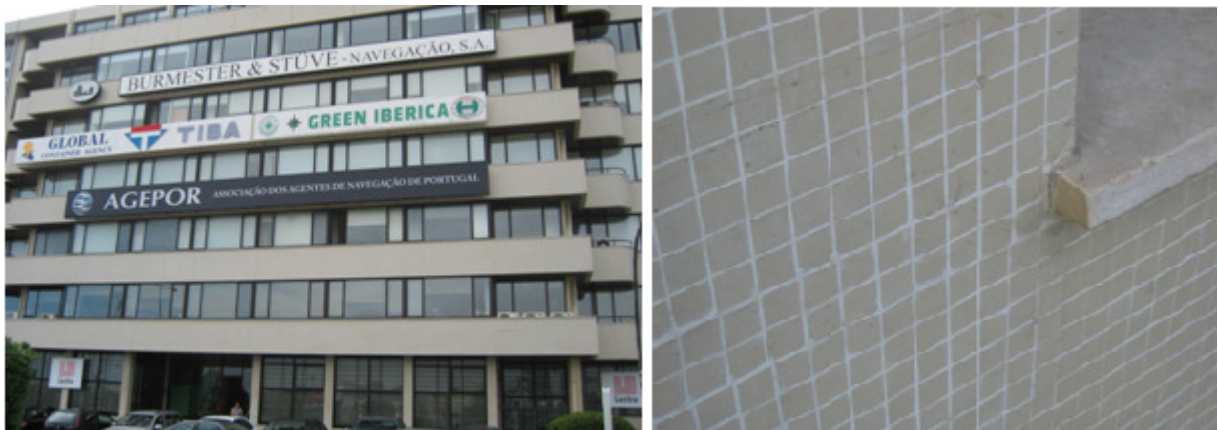
Figura 4.19 - Edifício revestido com pastilha/azulejo não vitrificado e pormenor
