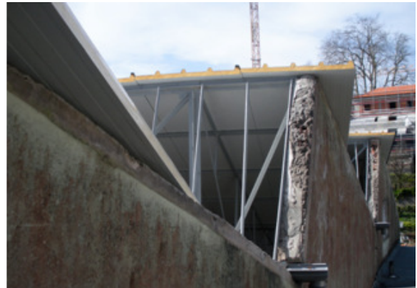
Figura 4.10 - Reabilitação de cobertura em fibrocimento, com remoção
