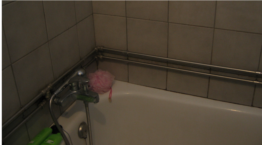
Figura 4.27 - Reabilitação de ramais de alimentação pelo exterior
