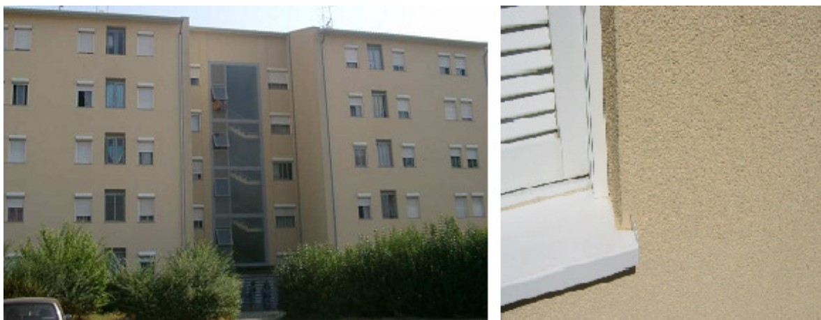
Figura 4.18 - Edifício revestido com sistema ETICS
