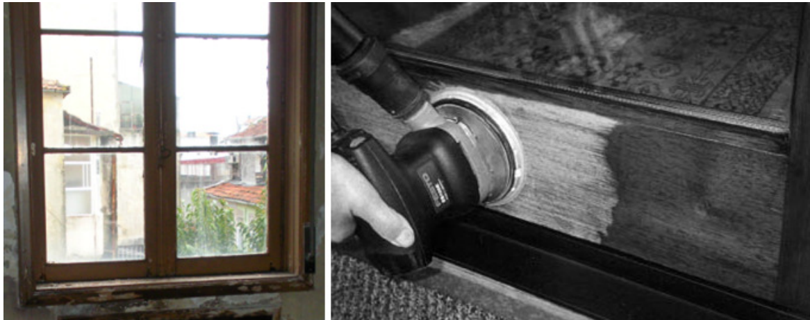
Figura 4.23 - Caixilharia de madeira e respectivo tratamento [45]
