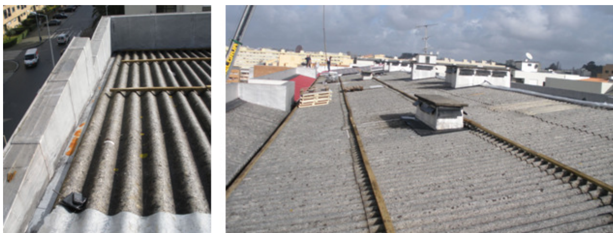
Figura 4.9 - Cobertura em fibrocimento
