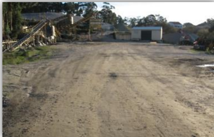
Figura 24: Exemplo do estado da pista de circulação – circuito britagem
