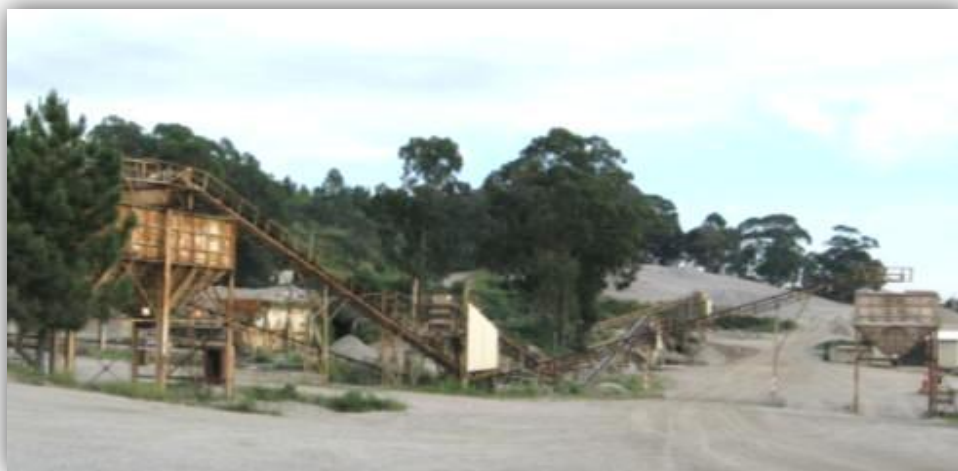
Figura 17: Vista geral da Instalação de britagem
