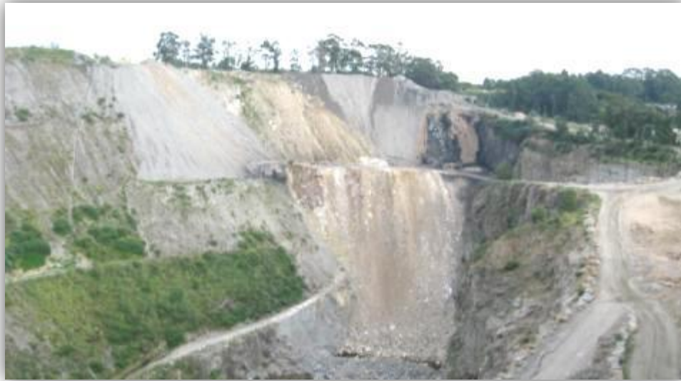
Figura 18: Vista geral do aterro de inertes
