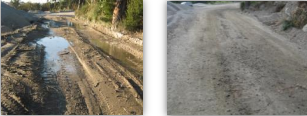
Figura 22: Exemplo do estado da pista de circulação antes e depois da manutenção
