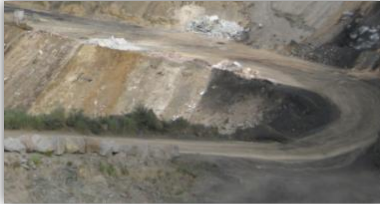
Figura 25: Exemplo do estado da pista de circulação – aterro
