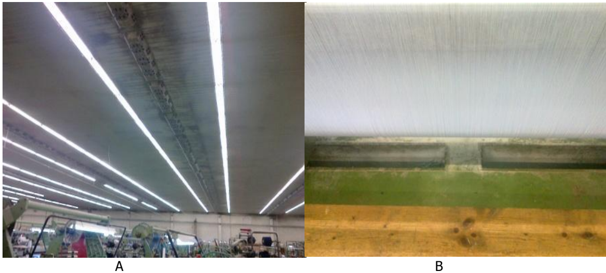
Figura 23 – Sistema de ventilação da Tecelagem: A-Insuflação, B-Aspiração
