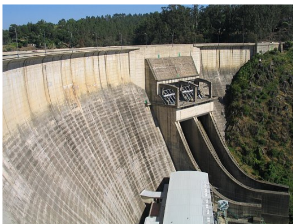
Figura 1.4 – Barragem de Castelo de Bode, exemplo de uma barragem cuja uma das funções é defesa contra cheias (Osvaldo Gago)
