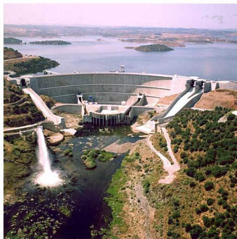
Figura 1.2 – Barragem de Alqueva, exemplo de uma barragem cuja uma das finalidades é armazenar água para rega (autor desconhecido).
