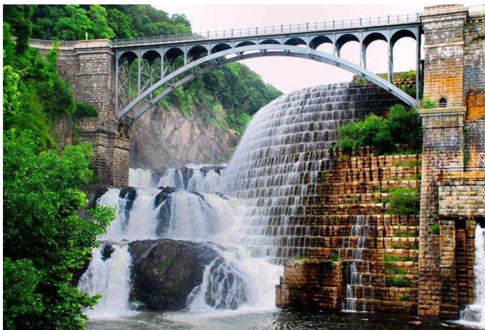
Figura 2.2. Descarregadores de cheia em degraus. a) Descarregador em gabiões, b) Descarregador com soleira em degraus não revestida, c) Descarregador de cheias em degraus da barragem de New Croton, EUA
