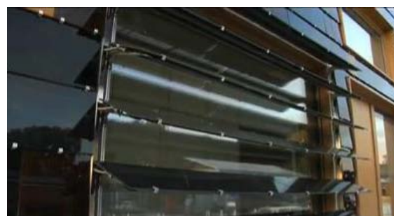
Figura 2.44 – Fachada com painéis fotovoltaicos, com ancoragem por grampos [42]
