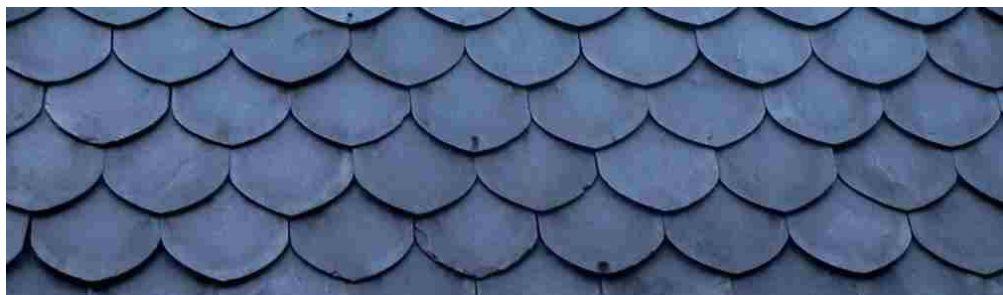
Figura 2.18 – Fachada em soletos de ardósia [19]
