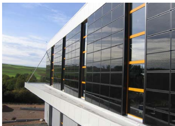
Figura 2.43 – Esquema de fachada com painéis fotovoltaicos (esq.) e sua aplicação num edifício (dir.) [42]
