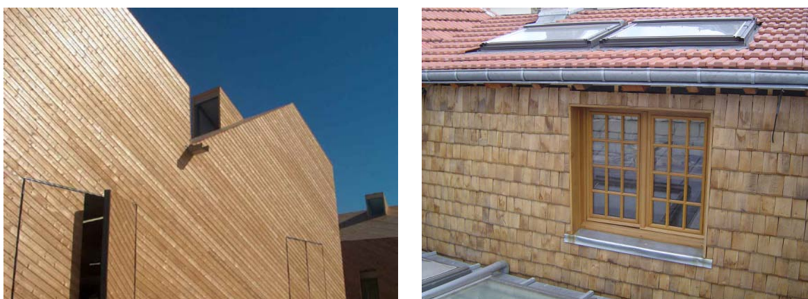
Figura 2.39 – Fachada em madeira maciça em ripado (esq.) e elementos de reduzida dimensão (dir.) [38]
