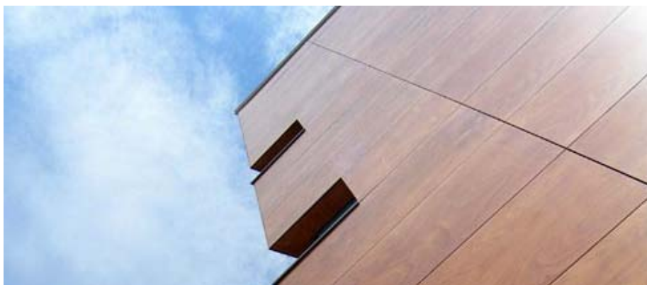
Figura 2.38 – Fachada ventilada em fenólico de folha de madeira [37]
