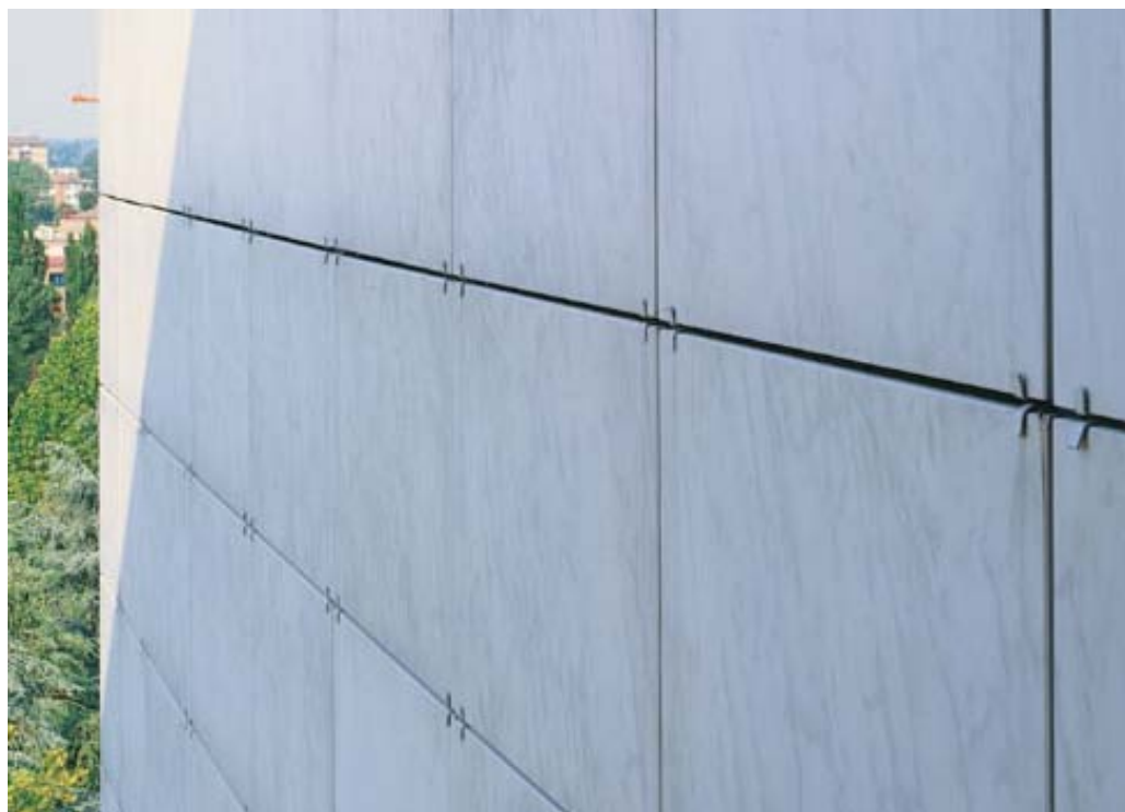
Figura 2.16 – Ancoragem por grampos [17]
