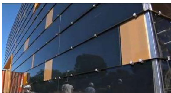
Figura 2.44 – Fachada com painéis fotovoltaicos, com ancoragem por grampos [42]
