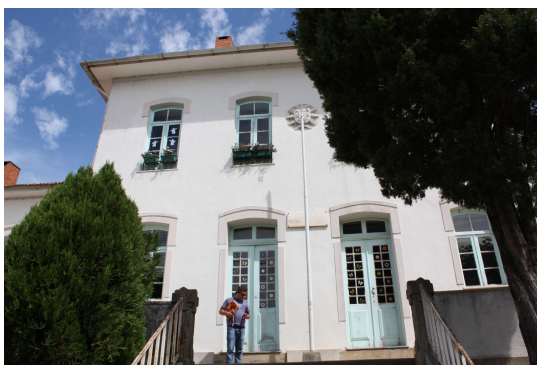
Edifício existente a preservar
