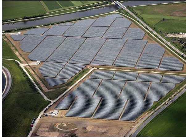
Figura 2.8 - Central solar de 11 MW em Serpa, Portugal [20].
