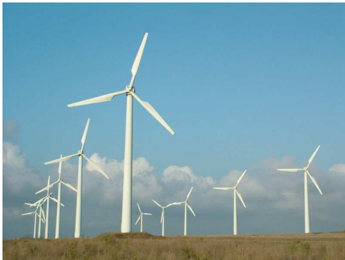
Figura 2.10 - Parte do parque eólico Sines [26].
