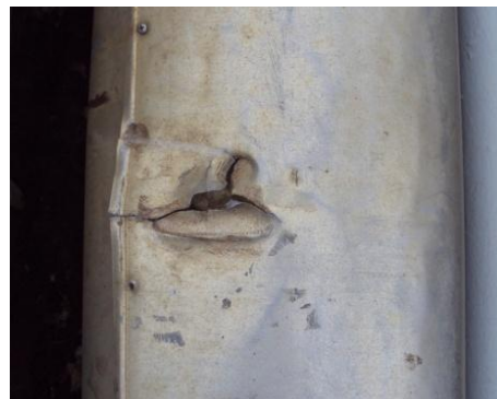
Figura 6 – Exemplo de uma falha mecânica numa linha
