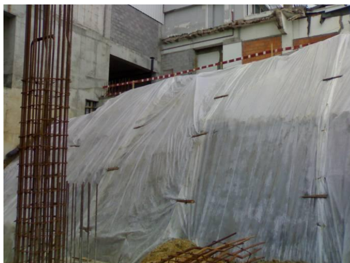
Figura 6 - Aplicação de geotexteis
