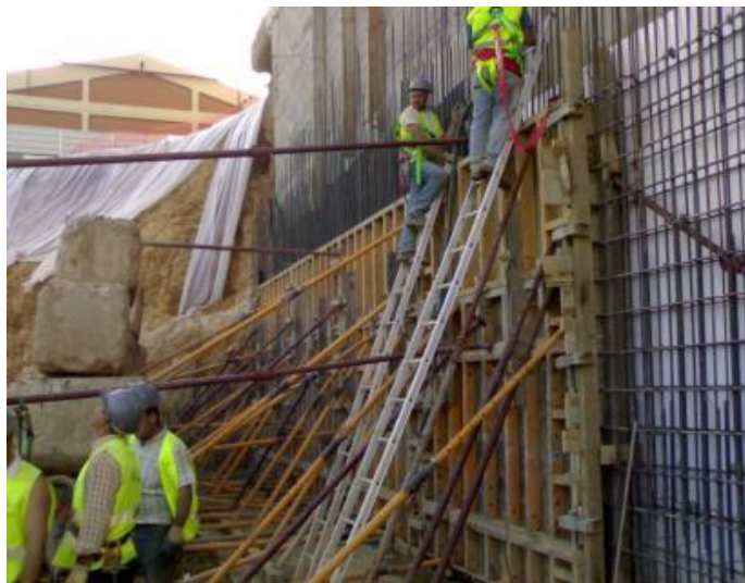
Figura 4 - Construção da parede de retenção
