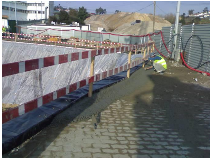
Figura 7 - Protecção dos geotexteis
