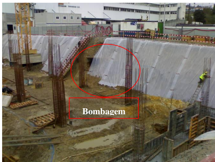
Figura 5 - Protecção de taludes
