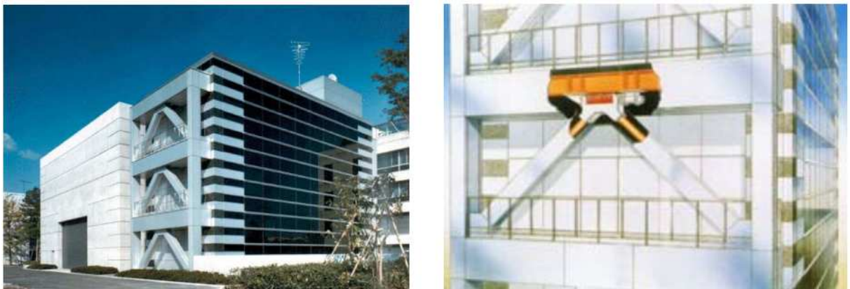
Figura 4.4 - Edifício do Kajima Technical Research Institute e respectivo AVSD [4.3]
