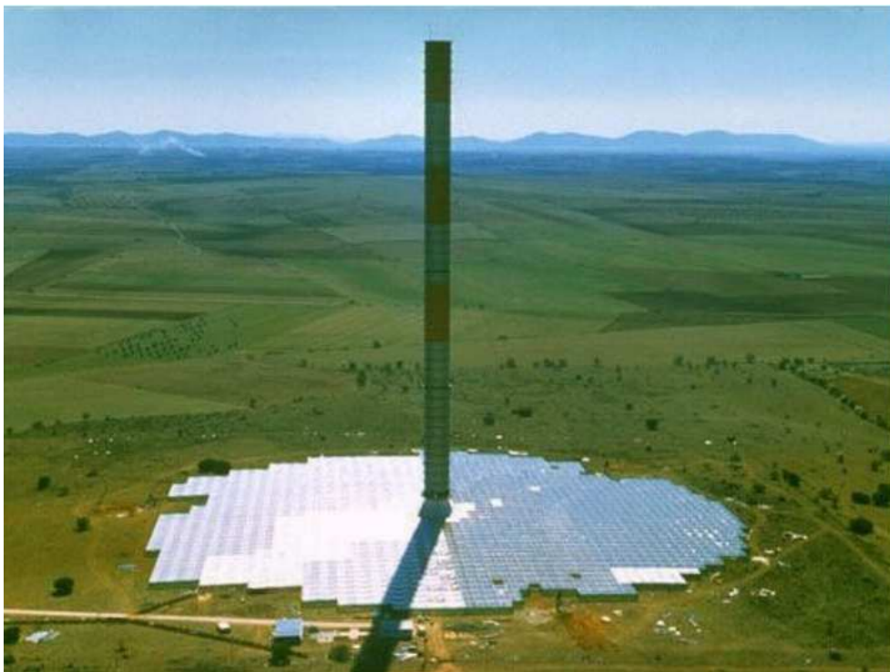
Figura 2.4 – Fotografia da chaminé solar em Manzanares, Espanha [2.3]
