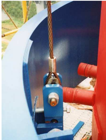
Figura 4.12 – Fotografia de um pormenor de um sistema TMD numa chaminé metálica
