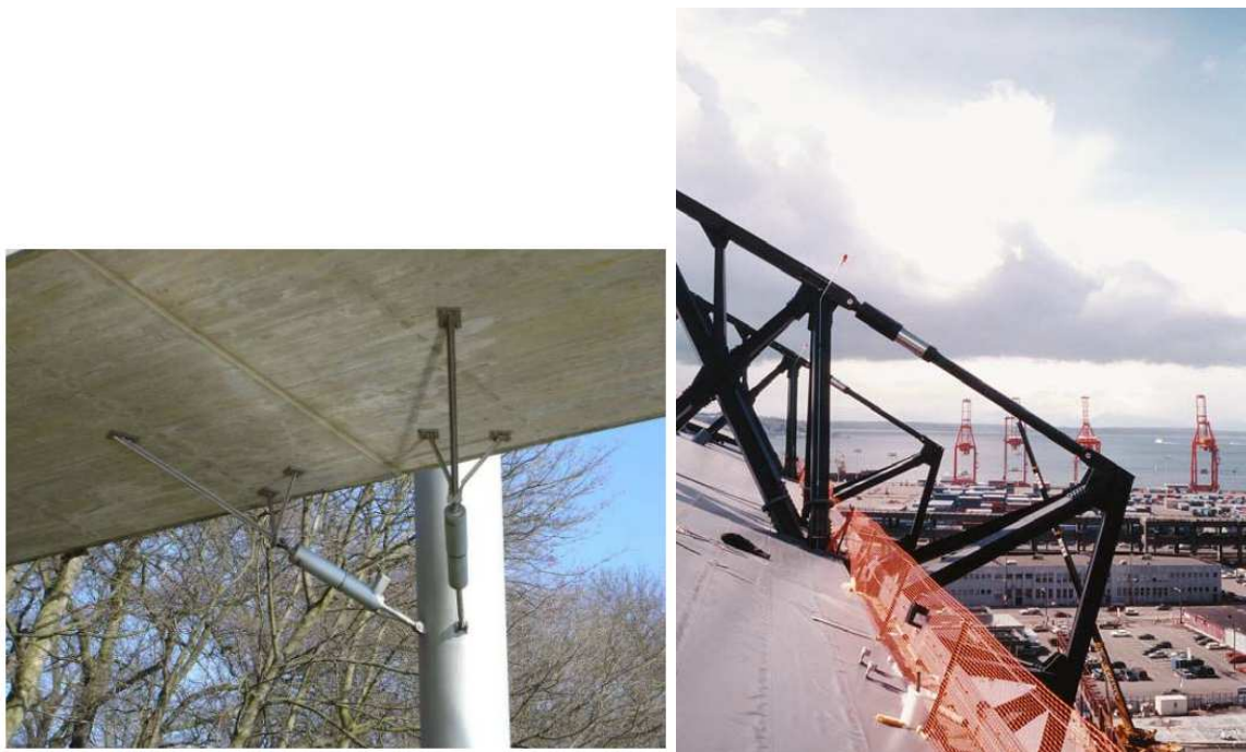
Figura 4.7 – Amortecedores viscosos: a) na ponte pedonal em Minden [4.3]; b) no estádio de Basebol Pacific Northwets [4.7]
