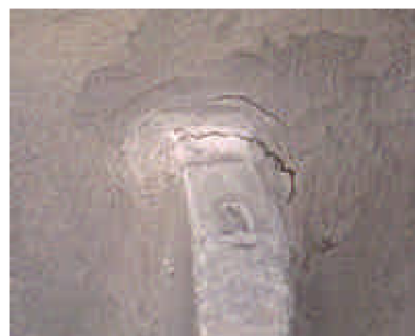
Figura 2.14 – Fotografia de uma fenda junto a um elemento soldado
