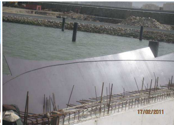
Fig. 4.3 – Cofragem da Ilha antes da betonagem.
