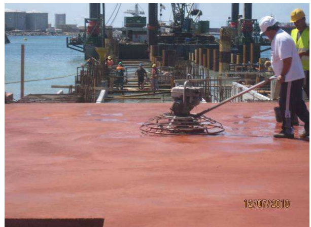
Fig. 3.88 – Acabamento superficial final.
