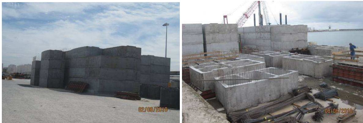
Fig. 2.36 – Fabrico e armazenamento em estaleiro de aduelas pré-fabricadas na obra exemplo.
