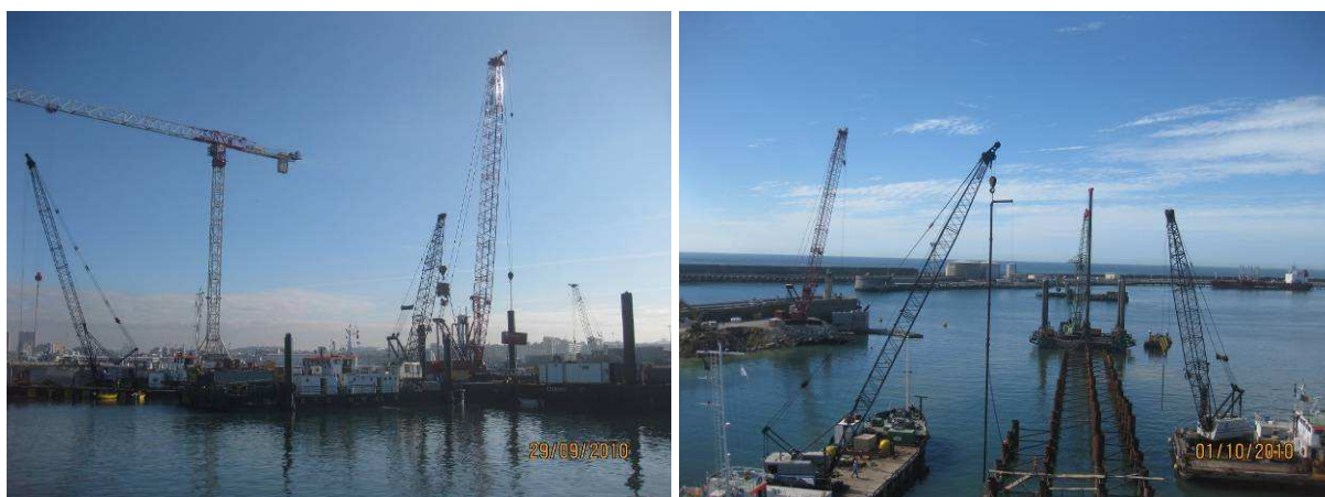
Fig. 5.2 – Grande disponibilidade de equipamentos em obra (gruas, batelões, plataformas).
