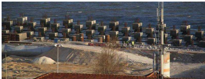
Fig. 2.64 – Cais acostável em estacas de betão armado construído parcialmente desde plataforma terrestre [62].
