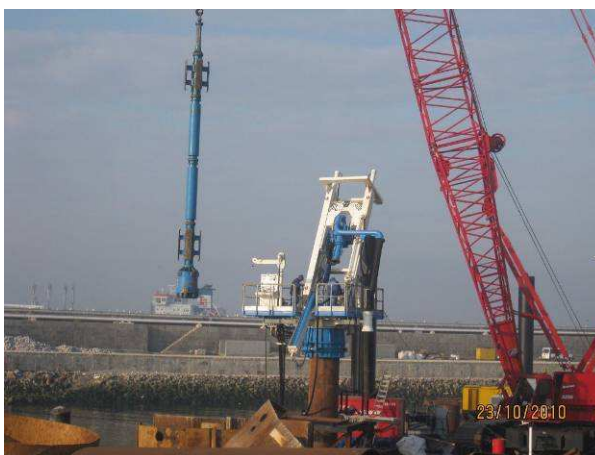
Fig. 3.105 – Coluna de furação com “bit” acoplado.
