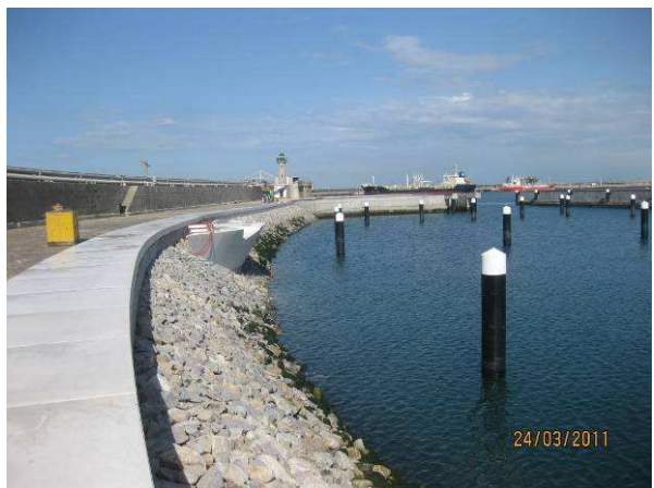
Fig. 3.61 – Reperfilamento do Molhe concluído.
