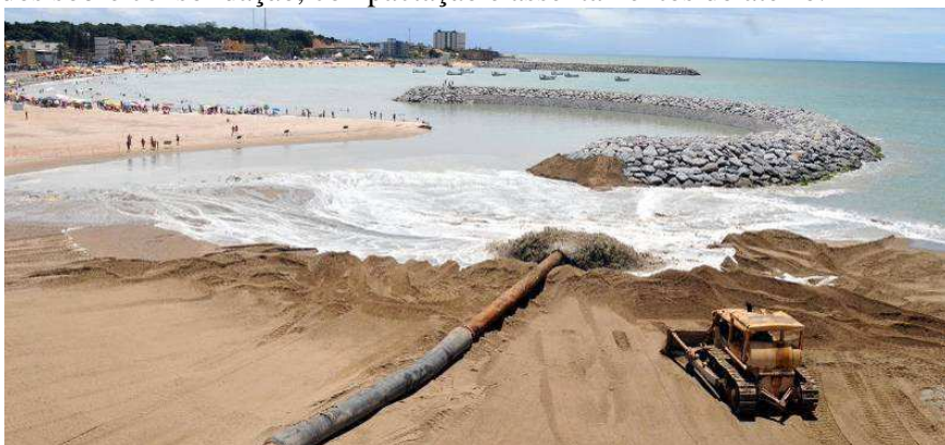
Fig. 2.45 – Aterro criado com descarga por tubagem de repulsão de uma draga [59].
