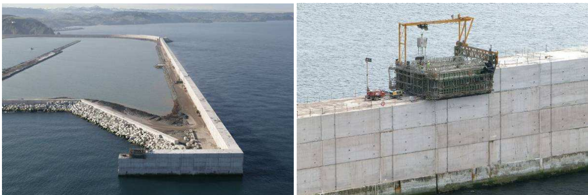
Fig. 2.58 – Construção do coroamento de um quebramar de parede vertical [70].
