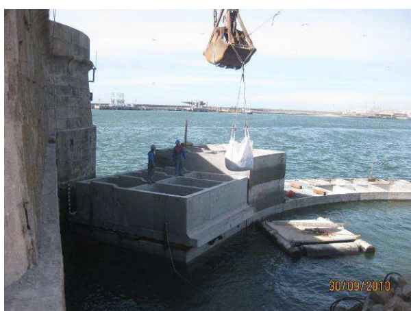
Fig. 3.126 – Início da sobrecarga nas aduelas.
