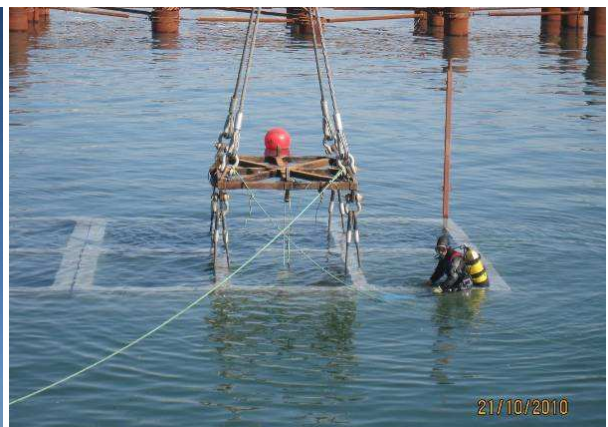
Fig. 4.13 – Colocação de aduela com mergulhador.
