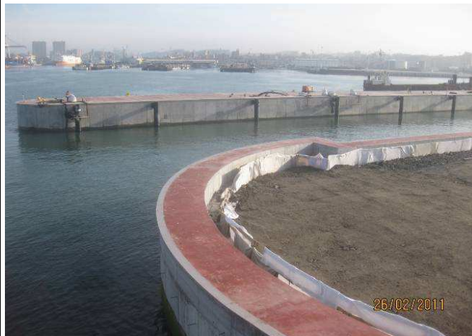
Fig. 3.133 – Viga de coroamento completa.
