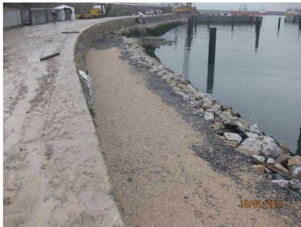
Fig. 3.59 - Trabalhos de reperfilamento do Molhe Sul.
