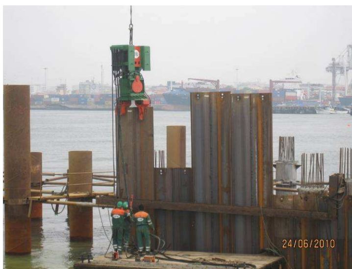
Fig. 3.76 - Cravação de estacas-prancha com “vibrofonceur”.
