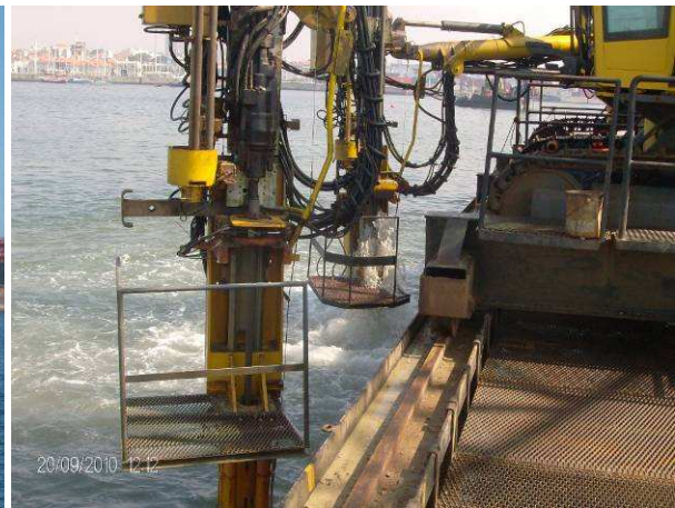
Fig. 3.44 - Atlas Copco ROC D7 em funcionamento.
