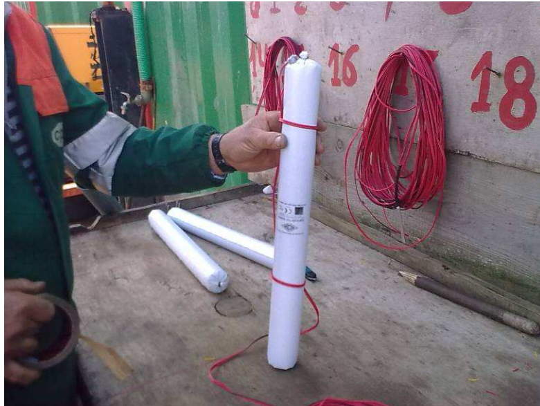
Fig. 3.38 - Preparação dos explosivos no pontão “Montemor” (25-02-2011).
