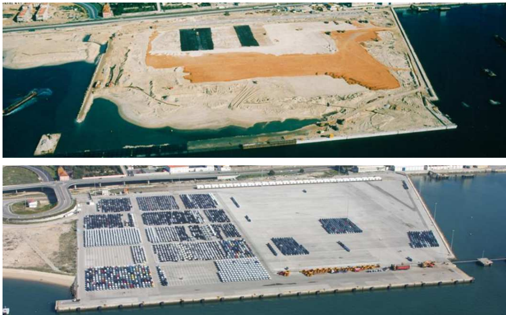
Fig. 2.44 – Aterro de 2.000.000m 3 do Terminal Roll-on Roll-off do Porto de Setúbal [58].
