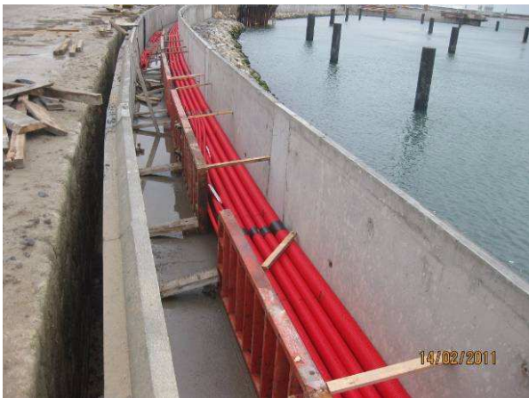
Fig. 3.60 – Execução da Galeria Técnica.
