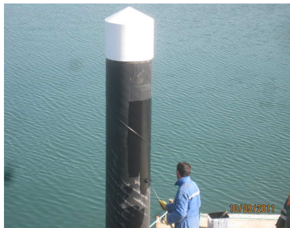
Fig. 3.109 – Estacas metálicas terminadas.
