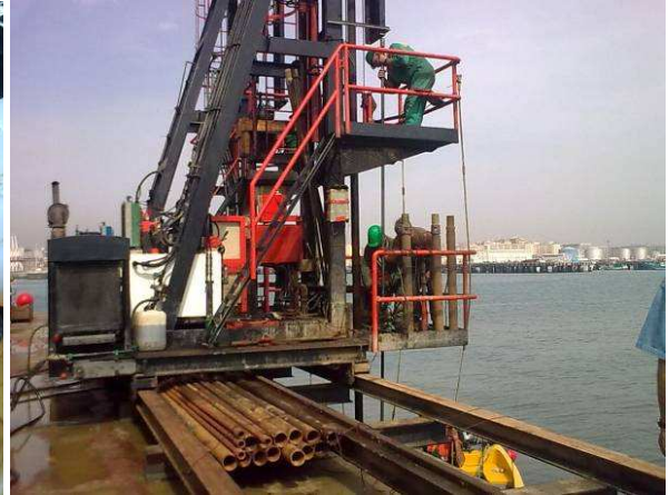
Fig. 3.42 - Torre de furação no “Montemor” (07-07-2010).
