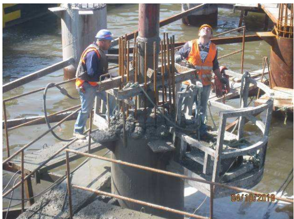
Fig. 3.74 – Fim da betonagem de uma estaca.
