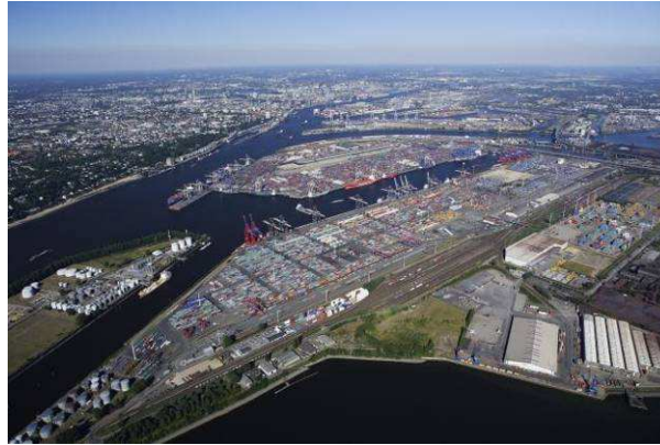
Fig. 2.3 – Porto de Hamburgo, Alemanha (exemplo de porto comercial artificial) [43].
