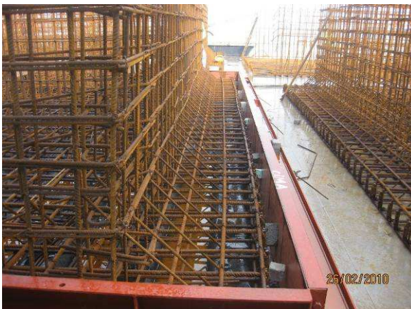
Fig. 3.136 – Armadura e cofragem de uma laje de fundo.
