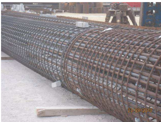
Fig. 3.68 - Empalme de armaduras das estacas.
