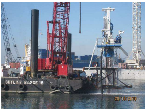
Fig. 3.104 – “Skyline Barge 18” em furação.
