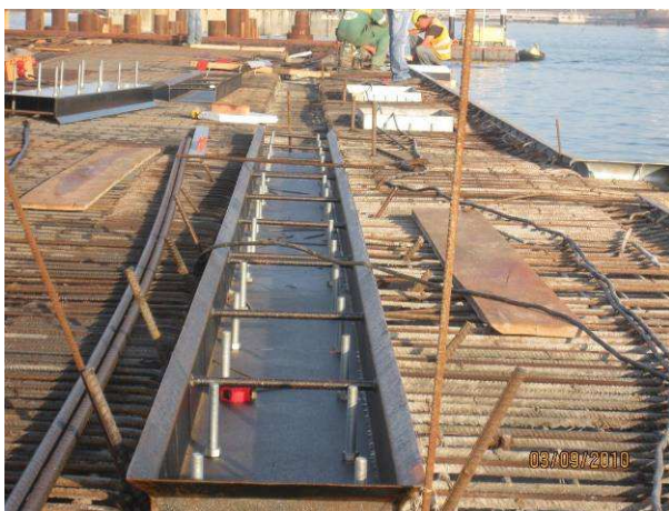
Fig. 3.97 – Negativo na laje e chumbadouros.
