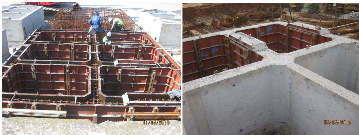
Fig. 3.138 – Armadura e cofragem de uma laje de fundo. Fig. 3.139 – Desmoldagem das células de uma aduela.
