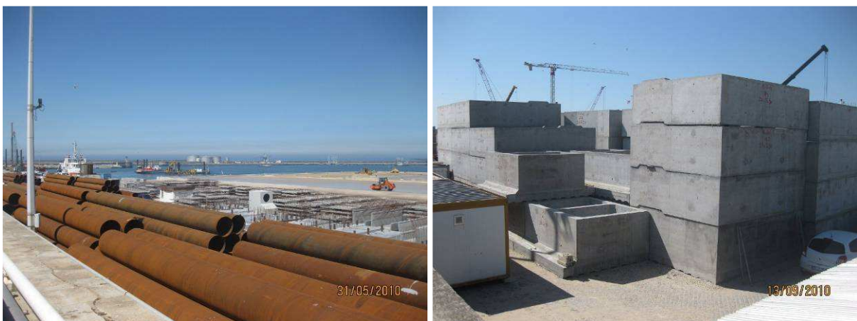
Fig. 5.7 – Armazenamento em estaleiro de moldes de estacas, pequenos pré-fabricados e de aduelas.
