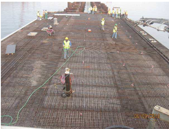
Fig. 3.87 – Início de uma betonagem de laje.
