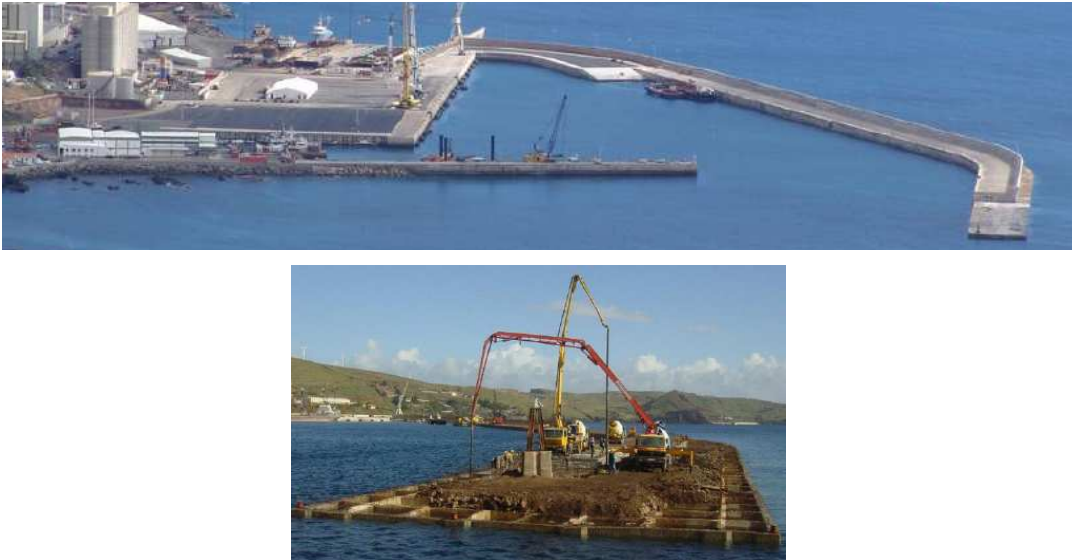
Fig. 2.56 – Quebramar exterior de parede vertical do Porto do Caniçal – Madeira [58].
