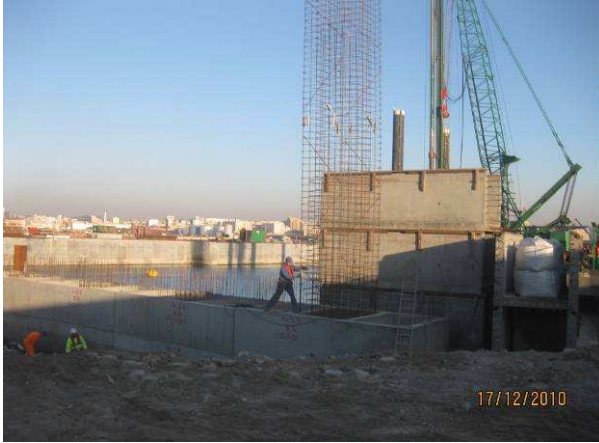
Fig. 3.128 – Colocação da armadura no pilar.
