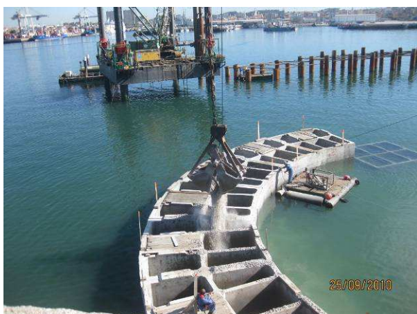
Fig. 3.125 - Preenchimento das células com brita.
