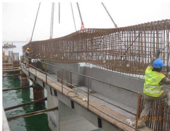
Fig. 3.84 – Colocação da armadura numa viga.
