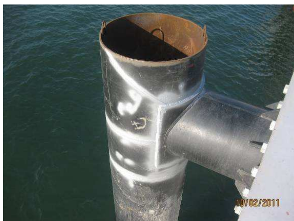
Fig. 4.11 – Tratamento anticorrosivo em estaca soldada.
