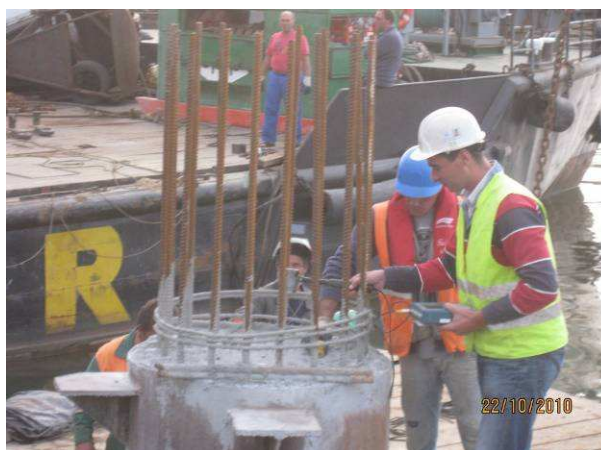
Fig. 3.75 – Ensaio sónico a uma estaca betonada.
