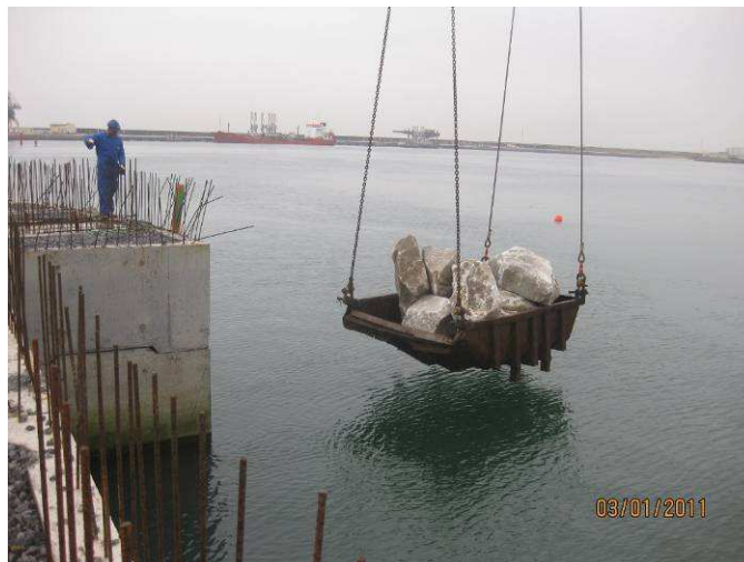
Fig. 3.56 - Protecção do prisma de fundação das aduelas com enrocamento numa cassamba. [25]
