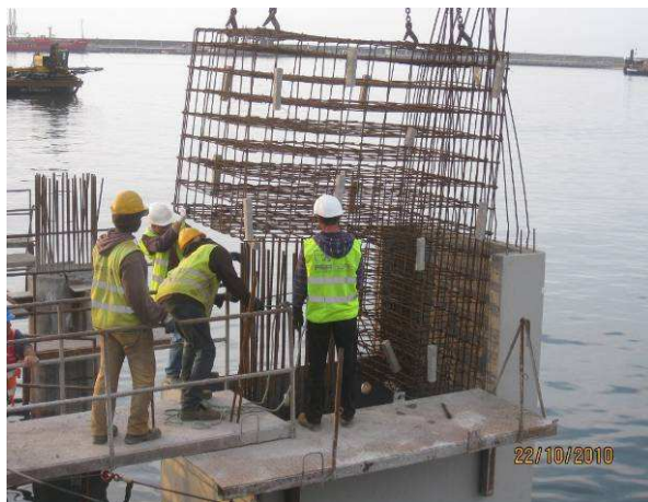
Fig. 3.82 – Colocação de armadura num escudete.
