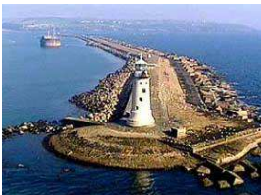
Fig. 2.2 – Porto de Plymouth, Reino Unido – Quebramar de protecção (exemplo de porto semi-natural) [42].
