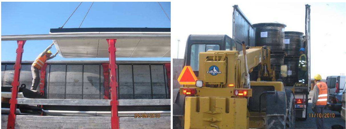
Fig. 4.16 – Recepção das defensas em obra.
