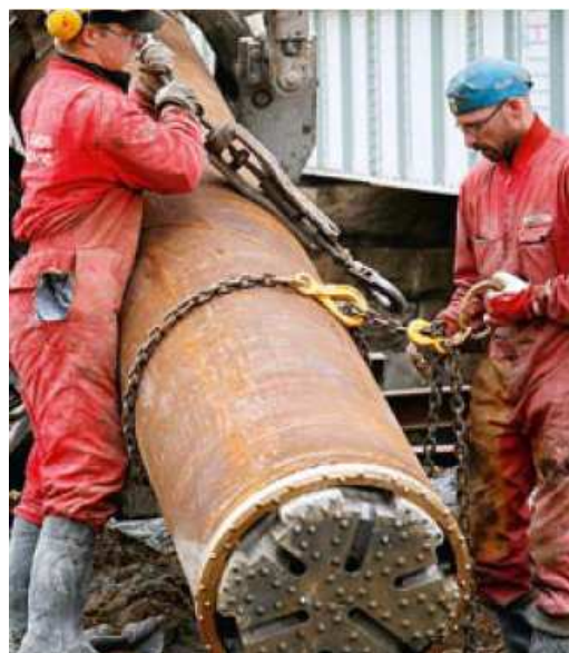
Fig. 3.107 – Estaca com sistema “Symmetrix” acoplado. [27]
