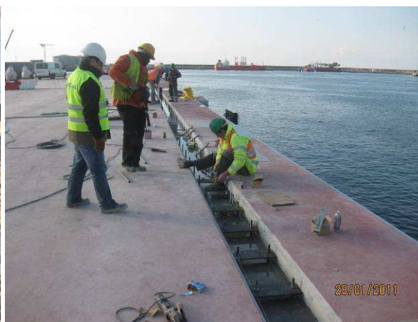
Fig. 3.98 – Negativo descofrado e mesas transversais.
