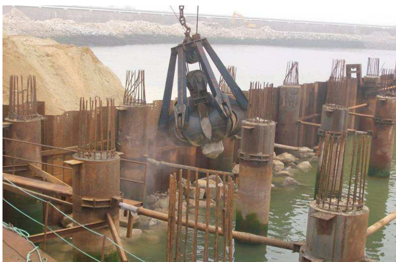
Fig. 3.50 – Fotografia da retenção marginal do cais acostável (26-06-2010).
