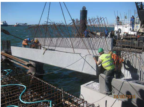
Fig. 3.83 – Colocação de um canalete pré-fabricado.
