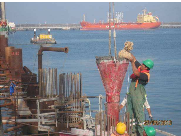
Fig. 3.72 – Colocação da "rolha" no "tremie".
