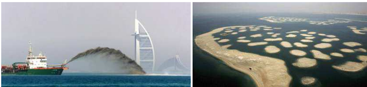
Fig. 2.43 – Construção de ilhas artificiais com dragas de sucção no Dubai [57].
