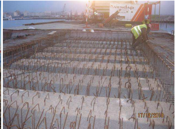
Fig. 3.86 – Colocação de uma série de pré-lajes.
