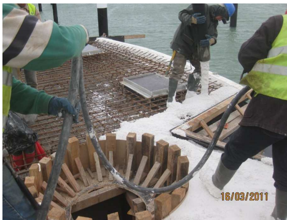
Fig. 3.112 – Betonagem da Ilha Ecológica.
