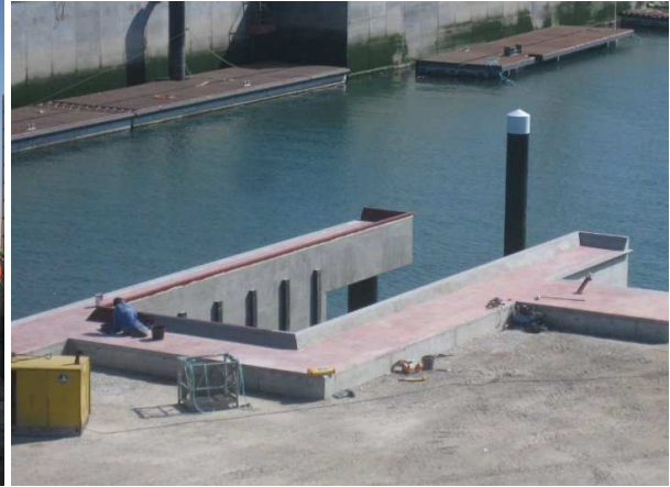
Fig. 3.129 – Estrutura do “travelift” (22-03-2011).
