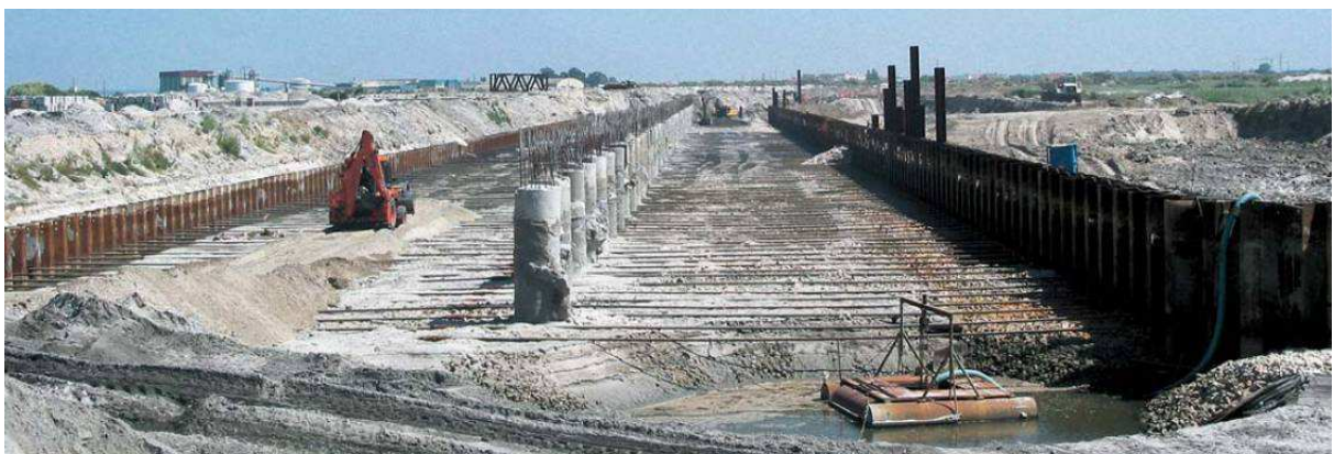
Fig. 2.77 - Construção de um cais acostável em doca artificial com estacas-prancha, recorrendo a equipamentos terrestres (paramento exterior, ancoragens e estacas em betão para fundação de uma viga de tardoz para suporte de carril de guindaste) [64].
