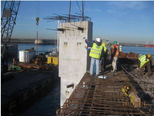
Fig. 3.85 – Colocação de um painel do intradorso.
