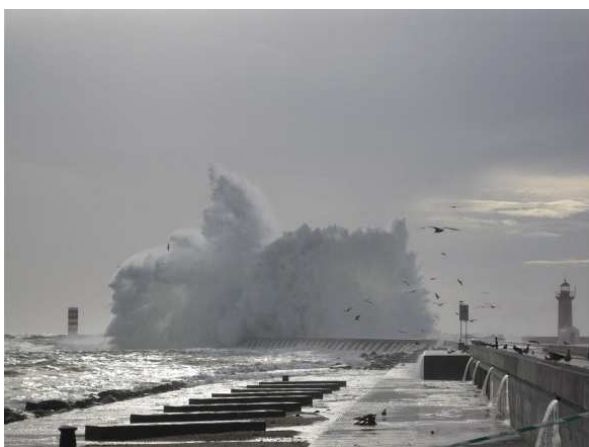
Fig. 5.5 – Galgamento do Molhe do Douro, um quebramar de parede vertical, perto do Porto de Leixões [17].
