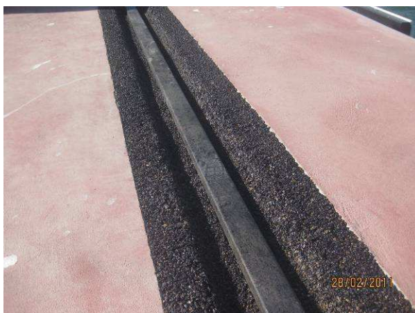
Fig. 3.100 – Acabamento final com betuminoso.
