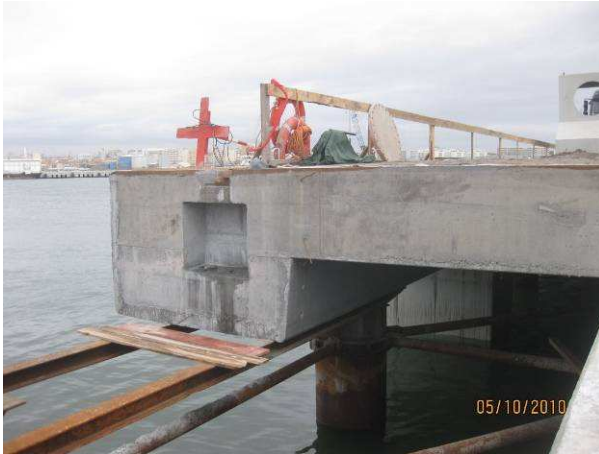
Fig. 3.93 – Negativo após descofragem.
