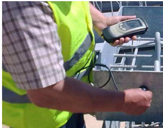
Fig. 4.9 – Medição da espessura da galvanização com medidor de sonda destacável (26-07-2011).
