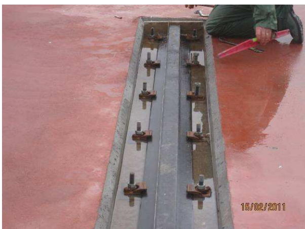
Fig. 3.99 – Colocação do carril sobre as mesas.
