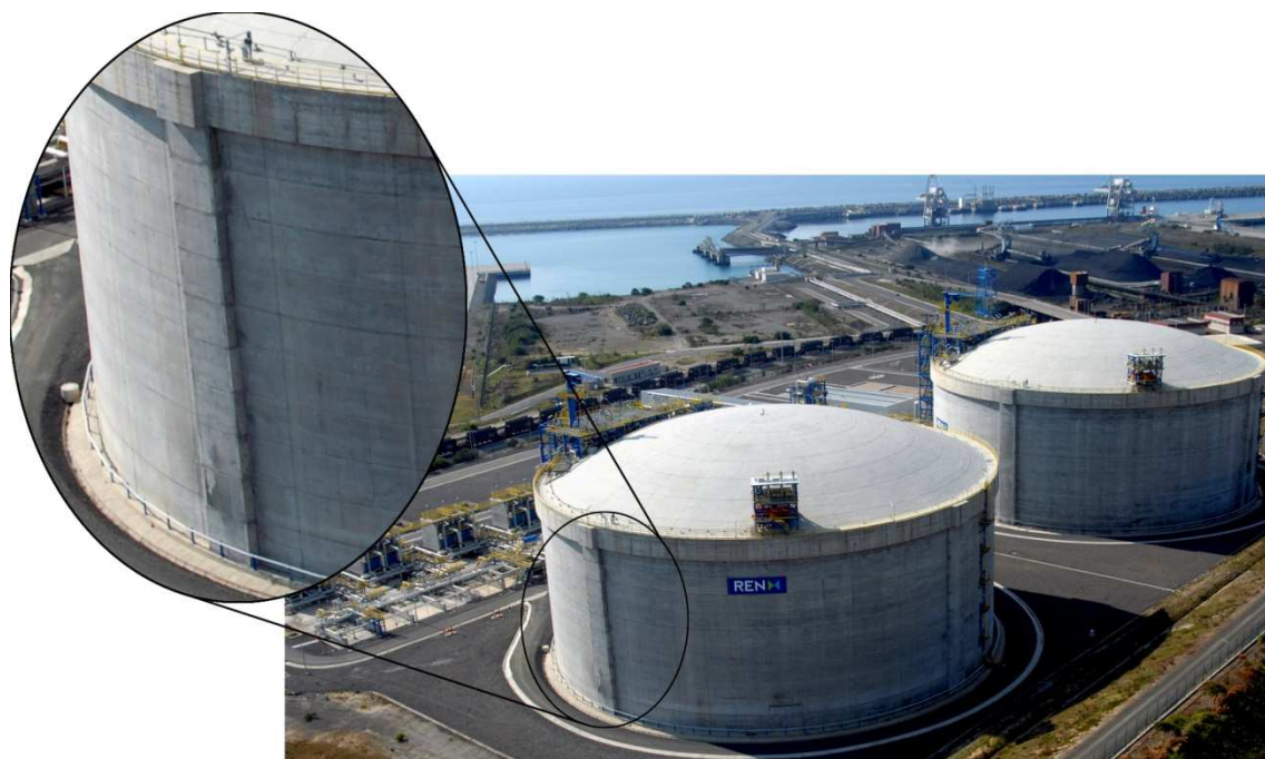
Figura 1.3 – Depósito pré-esforçado localizado no Terminal de Sines
