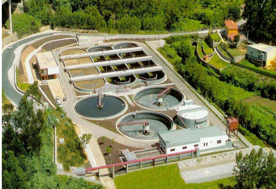
Figura 1.2 – Vista aérea das infra-estruturas de uma ETAR
