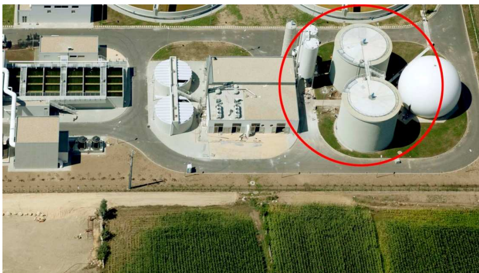
Figura 4.2 – Vista aérea dos Digestores Anaeróbios em estudo
