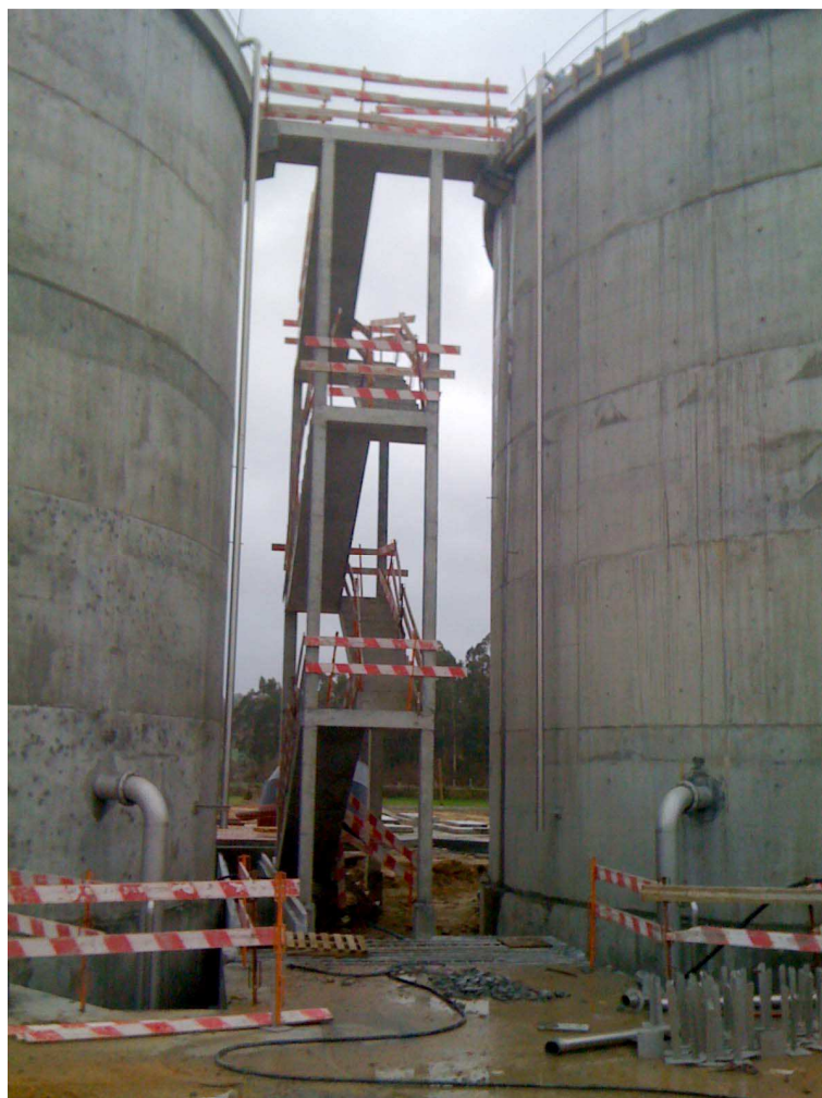
Figura 4.3 – Acesso à cobertura dos Digestores Anaeróbios
