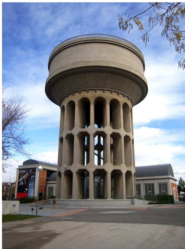
Figura 1.1 – Depósito elevado situado na praça de Castilla, Madrid
