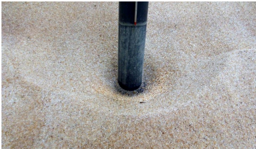
Figura v - Pormenor da cavidade de erosão final junto ao pilar (vista de montante).
