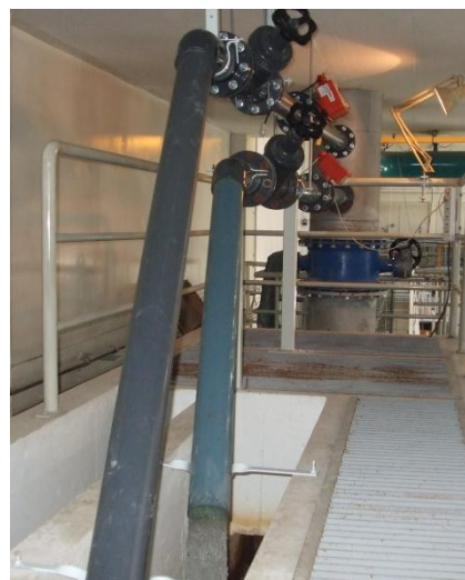
Figura 46 - Conduta principal e condutas de derivação da alimentação do canal
