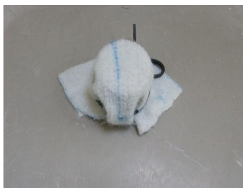
Figura 53 - Pormenor do dreno coberto com géotextil.
