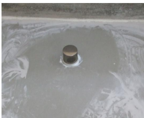
Figura 52 - Pormenor do dreno.
