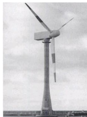
Figura 2.16Turbina eólica WKA 60 em Heligoland (Alemanha), 1990[8]
