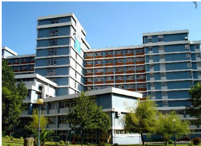
FIG. 22: Hospital da Prelada, Porto, exemplo de espaço acessível. Fonte: http://www.scmp.pt , acesso em 17.06.10
