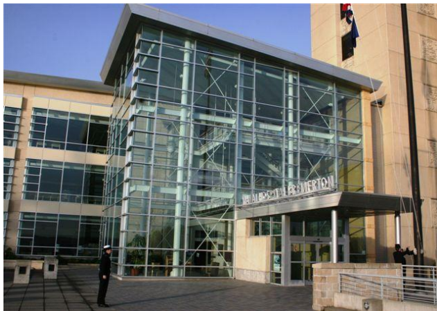
Fig.18: Hospital Naval de Bremerton (NHB), em Washington.
