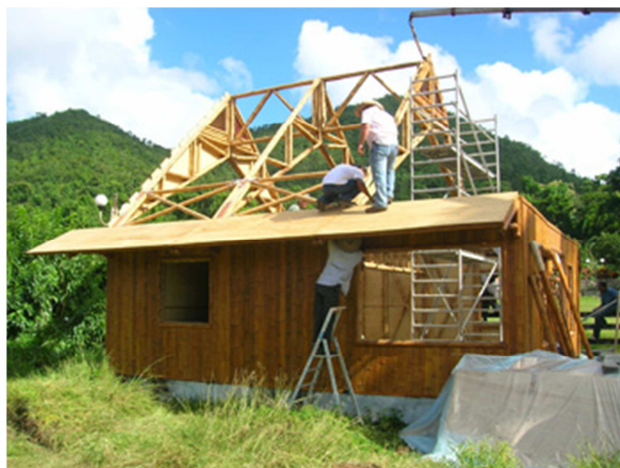
Fig. 39: Construção de uma casa em bambu [29]
