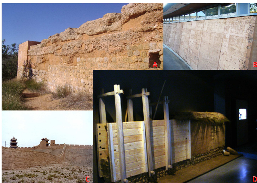
Fig. 41: A – Muralha antiga em taipa; B – Parede em taipa; C – Muralha da China construída em taipa; D – Modelo de construção de uma parede em taipa. [29]
