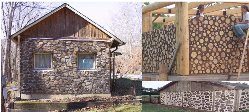
Fig:40: Paredes construídas com enchimento de lenha e restos de madeira [20]
