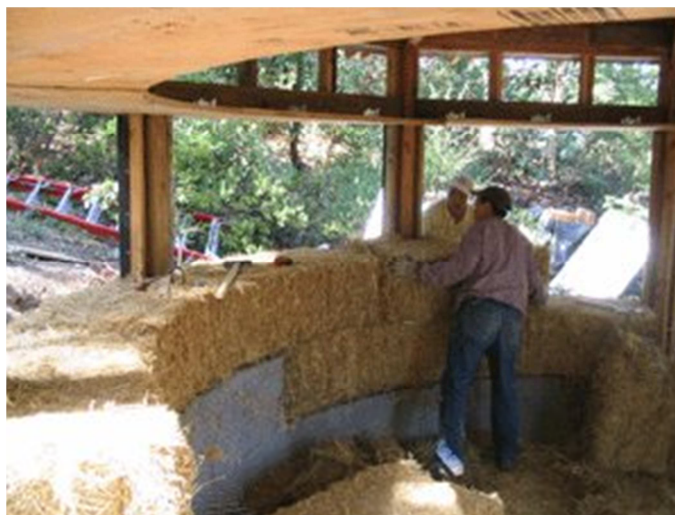
Fig. 38: Construção de uma parede com fardos de palha [29]
