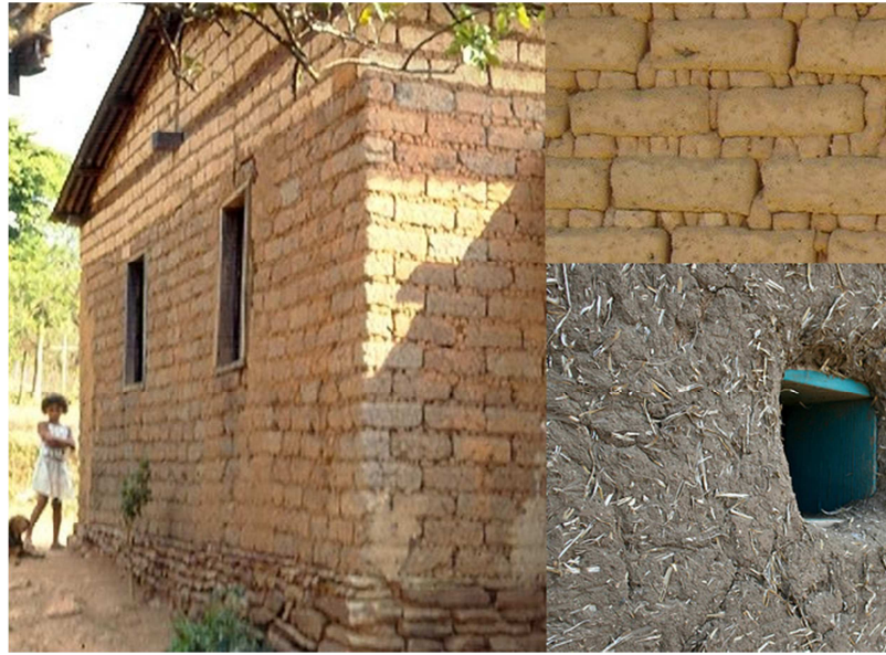
Fig. 43: Paredes construídas com blocos de adobe [20]
