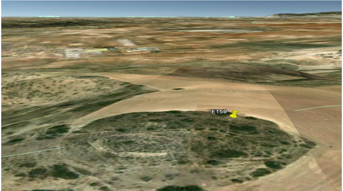
Figura 3.18 - Alusão ao terreno da torre E159
