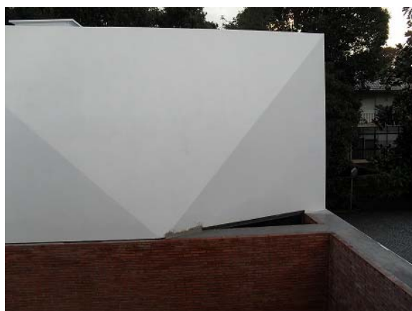
Fig.62 – Parede de Tipo 5 – Parede exterior inclinada triangular
