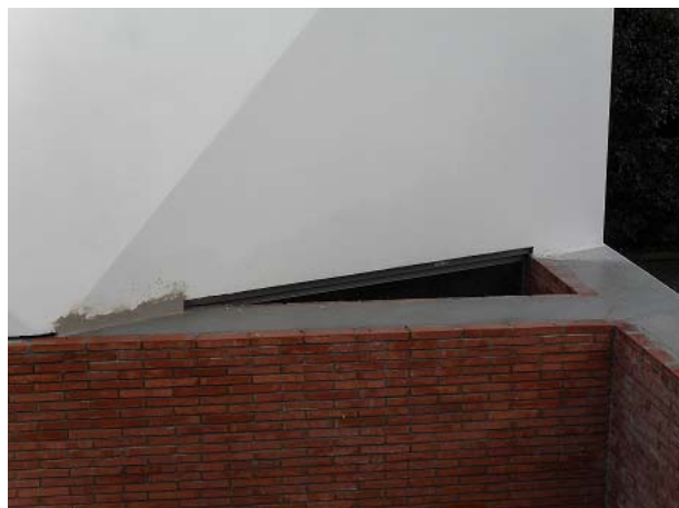
Fig.70 – Pormenor de espaço exterior – Entrada de luz na sala e cave
