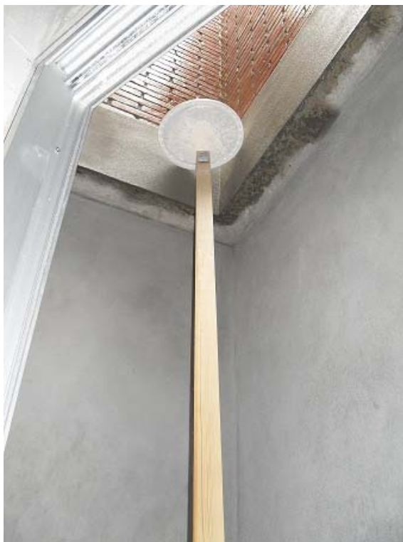
Fig.79 – Colocação do sensor 15 no exterior
