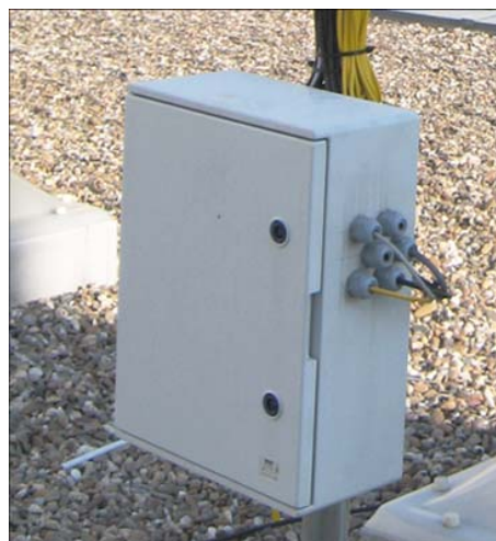
Fig.23 – Sistema de aquisição de dados – Guarda a informação registada pela estação [14]
