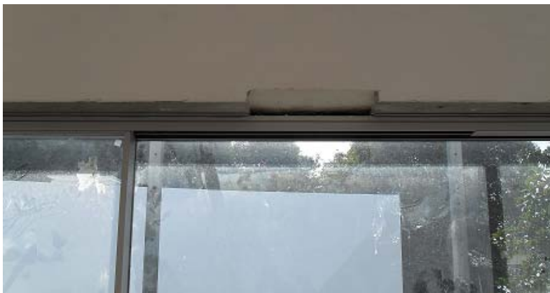
Fig.74 – Abertura para ventilação natural
