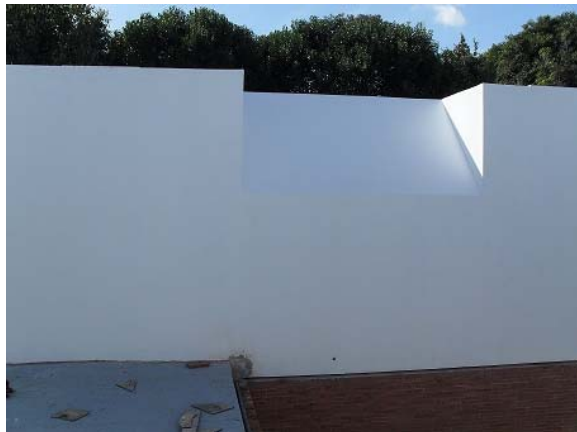
Fig.61 – Parede de Tipo 5 – Parede exterior inclinada rectangular
