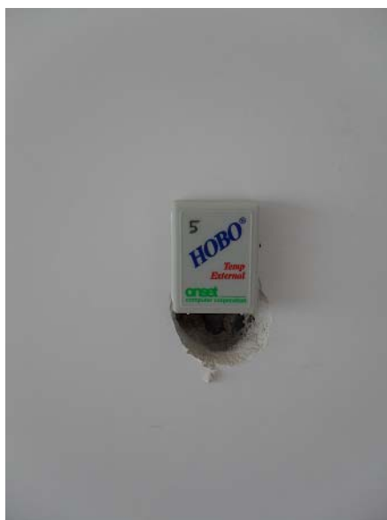
Fig.78 – Colocação do sensor 5 no piso 1
