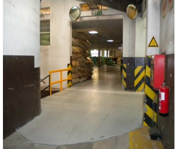
Ponte de passagem
