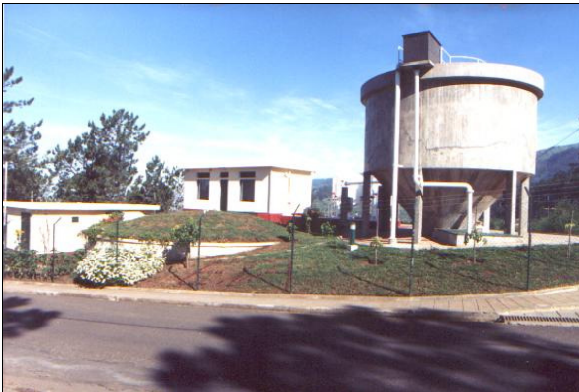
Figura 12 – ETA da Ribeira Brava
