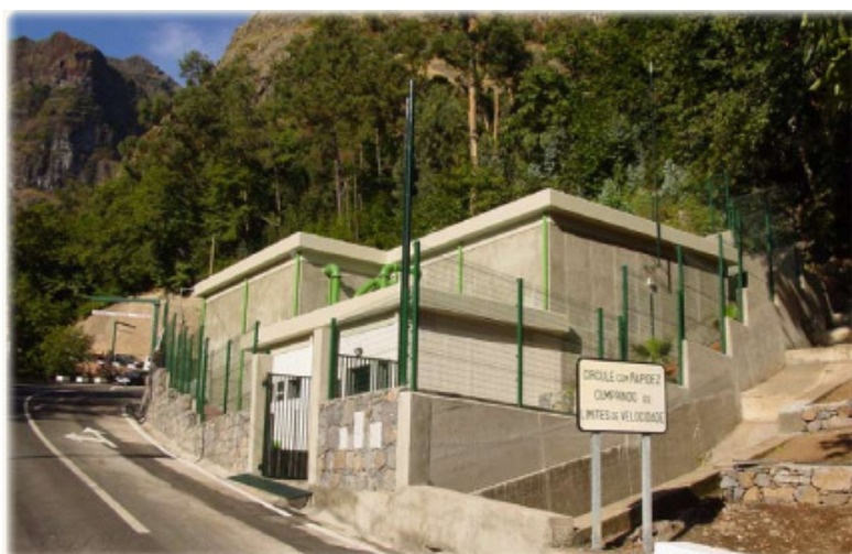
Figura 4 – Reservatórios de Águas
