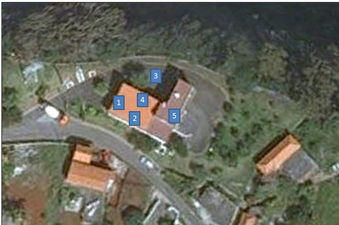
Figura 15 - ETA de Machico – Pontos de Medição
