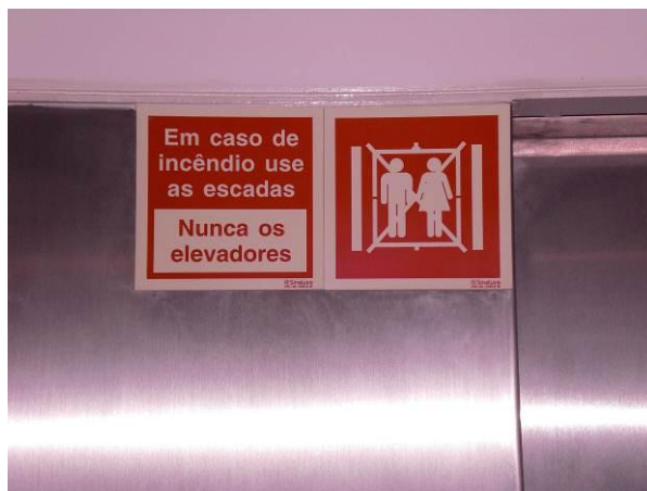
Fig. 5.32 – Sinal indicativo da não utilização do ascensor em caso de incêndio
