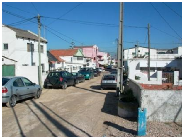
Fig.1: Construções ilegais e clandestinas na zona da Cova do Vapor.
