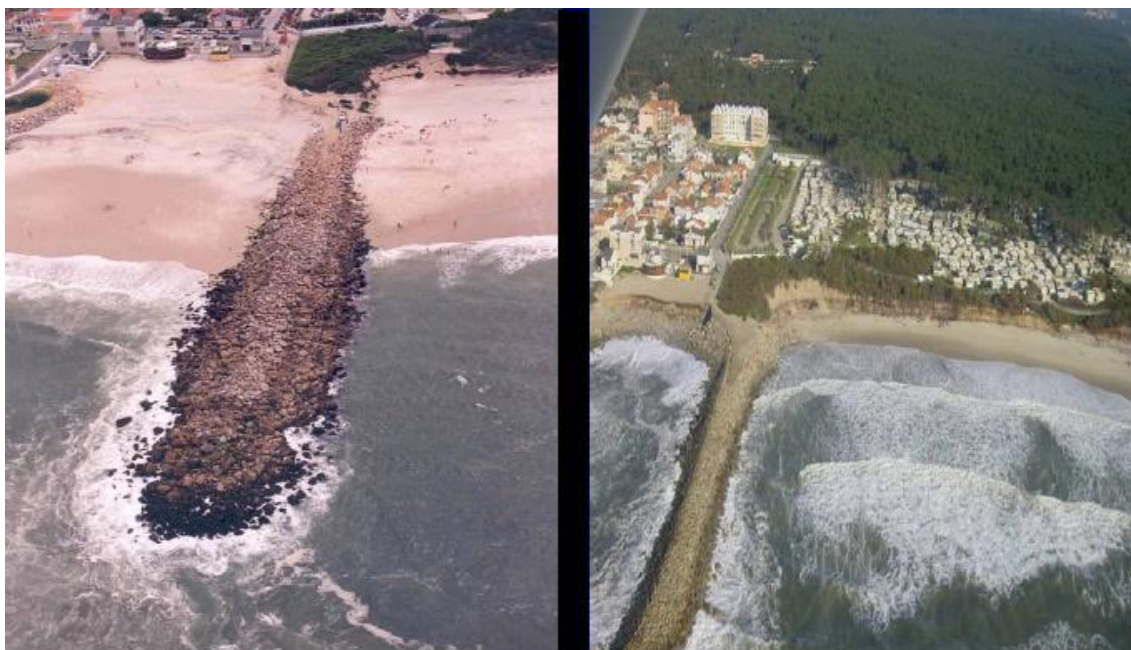
Fig. iii – Esporão norte de Cortegaça, antes e depois da sua reparação
