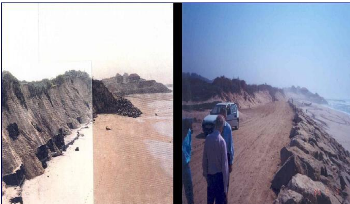
Fig. ii – Execução da defesa aderente ao longo do trecho de Esmoriz a Cortegaça.
