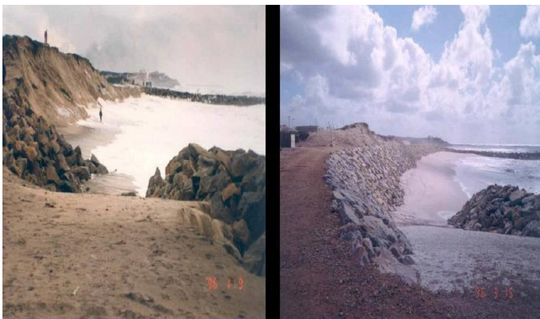
Fig. vi – Reparação da obra longitudinal aderente do troço que vai de Esmoriz a Cortegaça.
