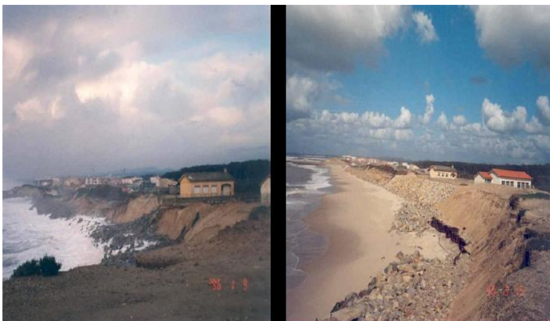
Fig. iv – Execução de um 2º patamar na defesa aderente de Cortegaça, em frente às escolas. Antes e depois da intervenção de emergência.
