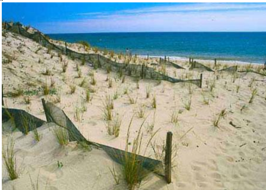
Fig. 16 – Recuperação dunar por paliçadas e vegetação (Rui Cunha, Naturlink)
