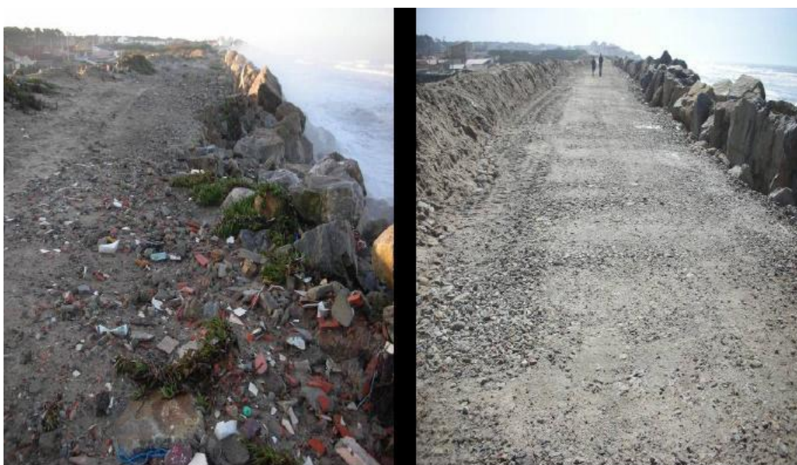
Fig. viii – Reparação de rombos na defesa aderente de Esmoriz, a sul do esporão sul.
