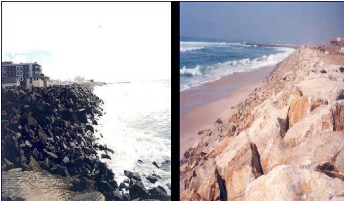
Fig. i – Quebramar Reperfilamento da defesa aderente em Esmoriz, na zona edificada
