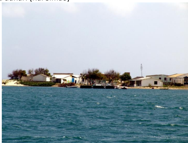
Fig.1: Construção em zona dunar. (Rui Simão)
