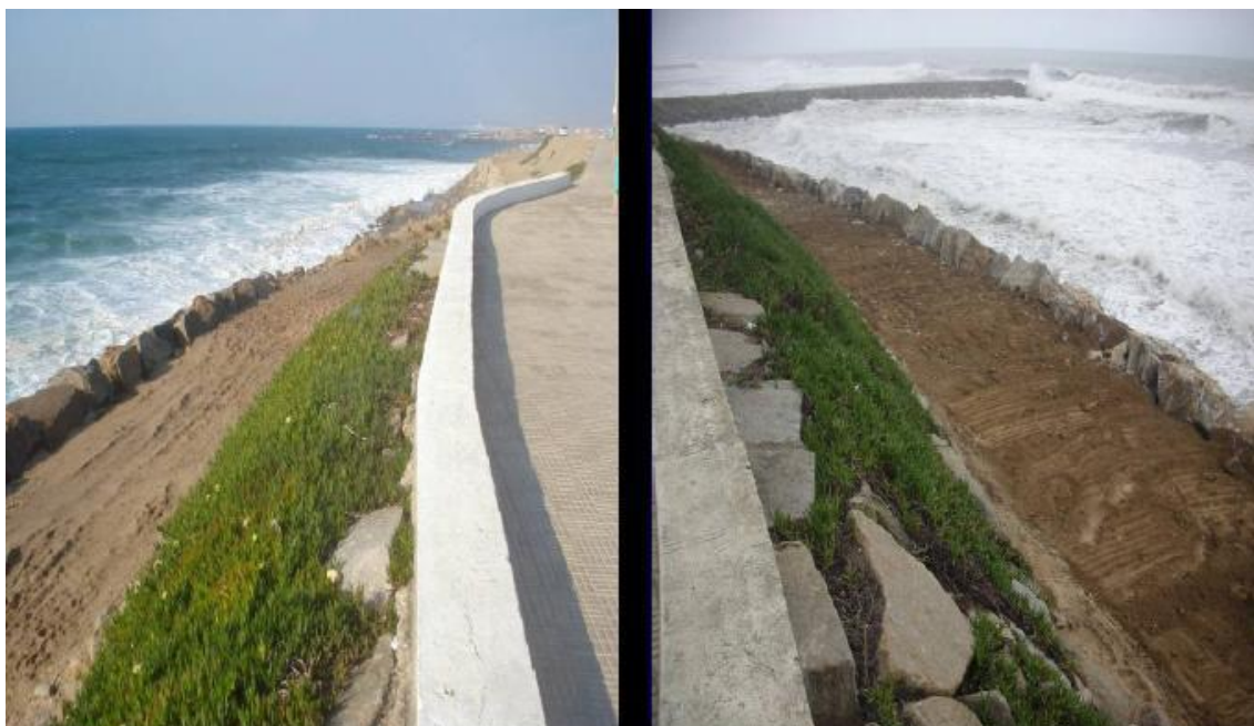
Fig. vii – Reparação de rombos na defesa aderente de Cortegaça, a sul das escolas.
