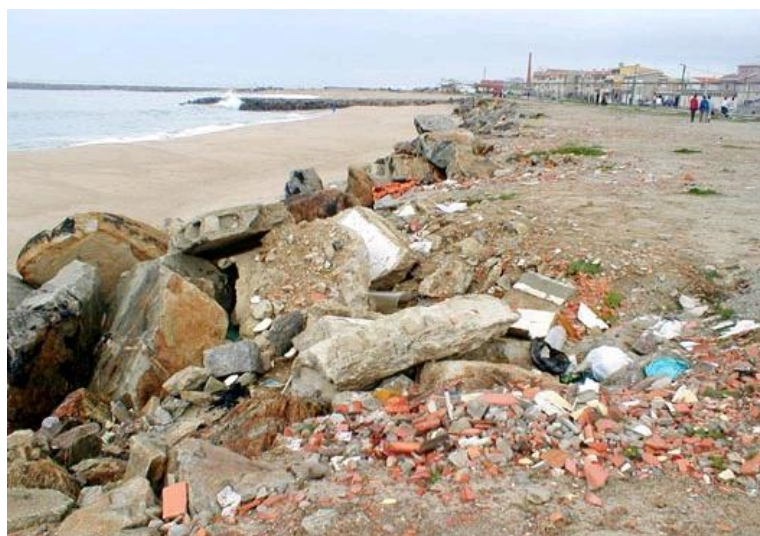
Fig.2 – Defesa aderente a sul da ribeira de Silvalde altamente deteriorada (actualmente já recomposta)
