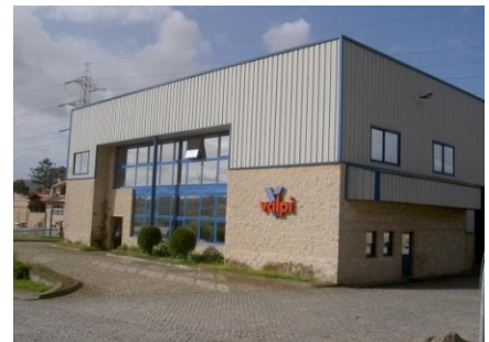
Figura 4 – Instalações Valpi Bus Paredes
