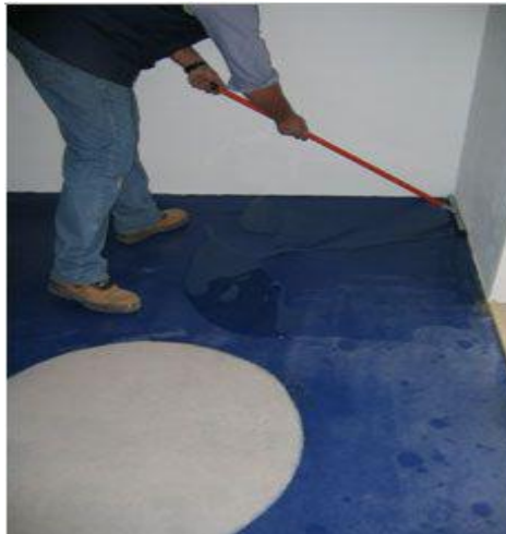
Fig. 56 – Aplicação de revestimento fino (Garcia, J.eBrito, J.).
