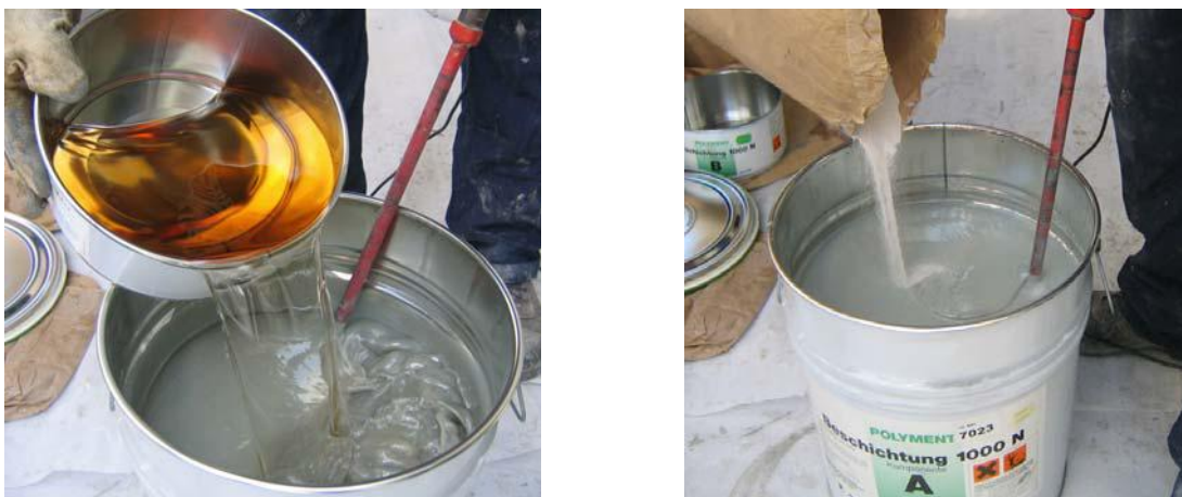
Fig. 16 – Processo de mistura (Garcia, J., 2006).
