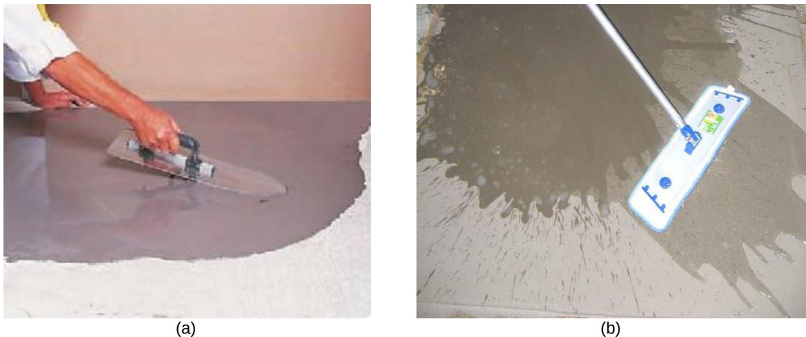
Fig. 19 – (a) Aplicação de argamassa; (b) aplicação do selante (Weber, 2010).
