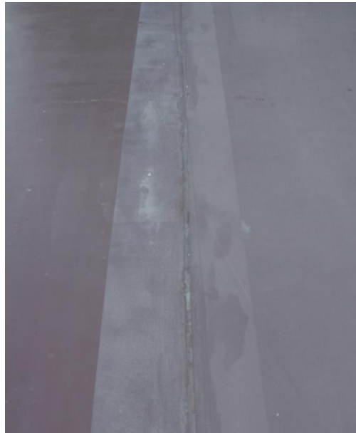
Fig. 49 – Reparação localizada de revestimento.
