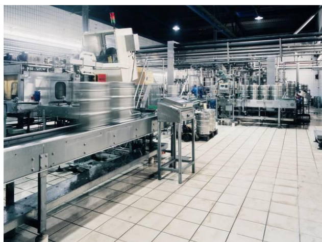
Fig. 58 – Revestimento cerâmico em pavimento industrial (Garcia, J., 2006).
