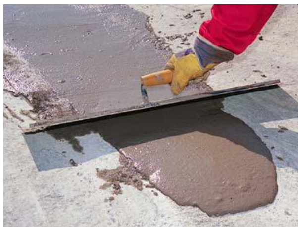
Fig. 12 – Preenchimento de fendas (Garcia, J., 2006).
