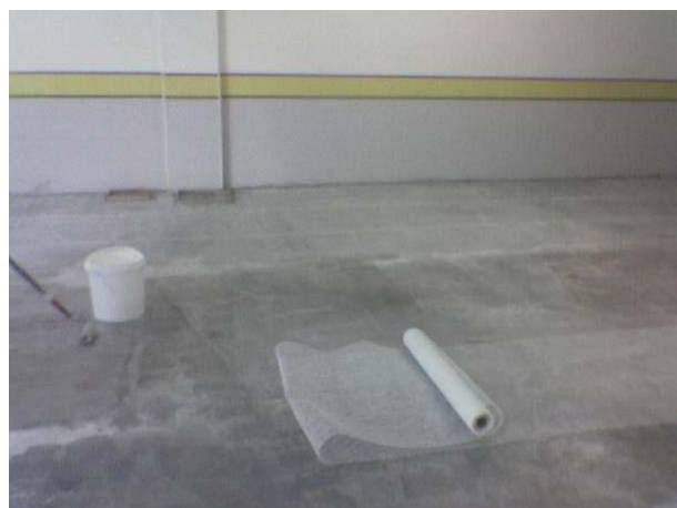
Fig. 20 – Aplicação de armadura de reforço (Garcia, J., 2006).
