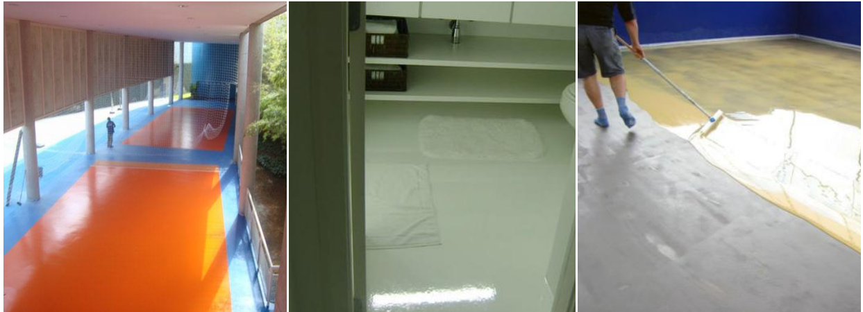
Fig. 7 – Revestimentos à base de resinas de poliuretano (Maxit).
