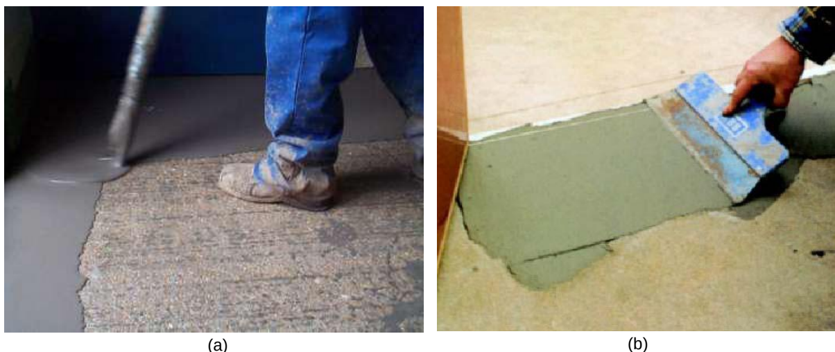
Fig. 57 – (a) aplicação de revestimento autonivelante (FeRFA, 1999); (b) execução de pendentes.
